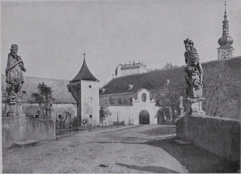
Abb. 272 Badener Tor und Brücke (S. 277, 283).
