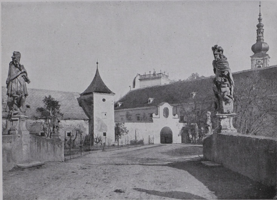
Abb. 272 Badener Tor und Brücke (S. 277, 283).
