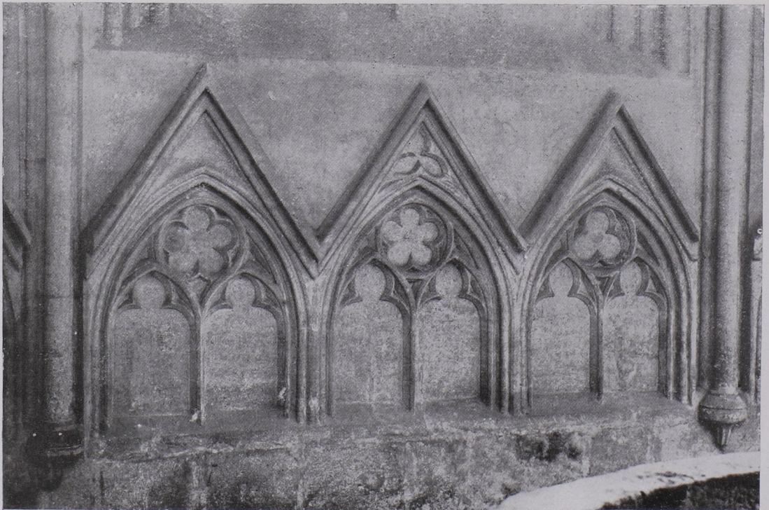
Abb. 77 Brunnenhaus, Sockelblende (S. 136).
