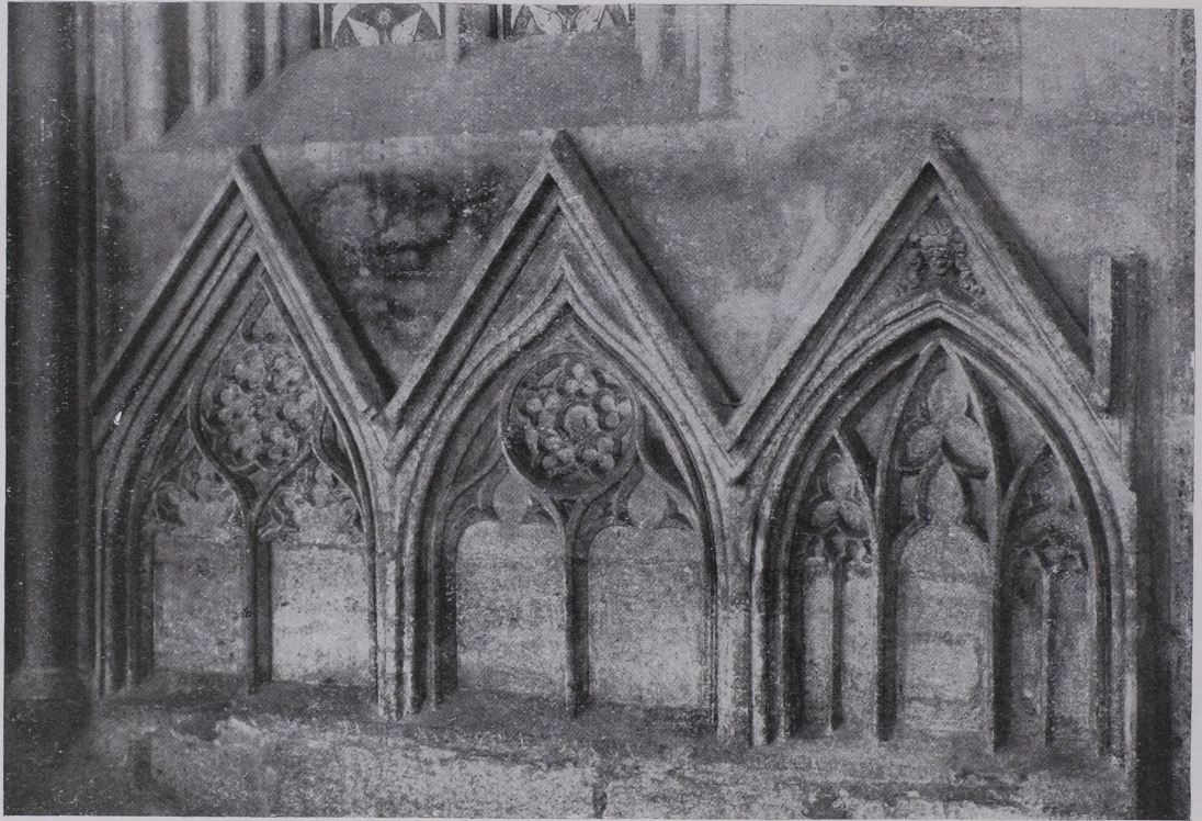
Abb. 76 Brunnenhaus, Sockelblende (S. 136).
