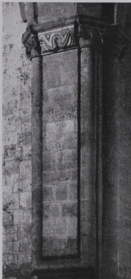
Abb. 26 Lisene am nordwestlichen Vierungspfeiler (S. 107).
