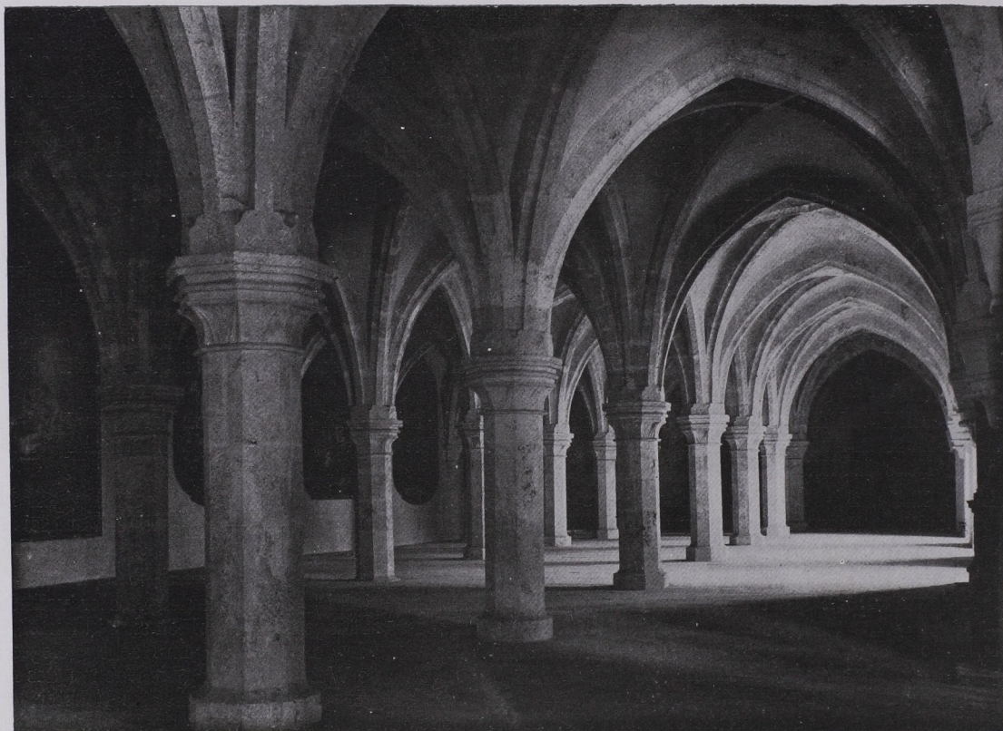
Abb. 89 Dormitorium, nördlicher (älterer) Teil (S. 149).
