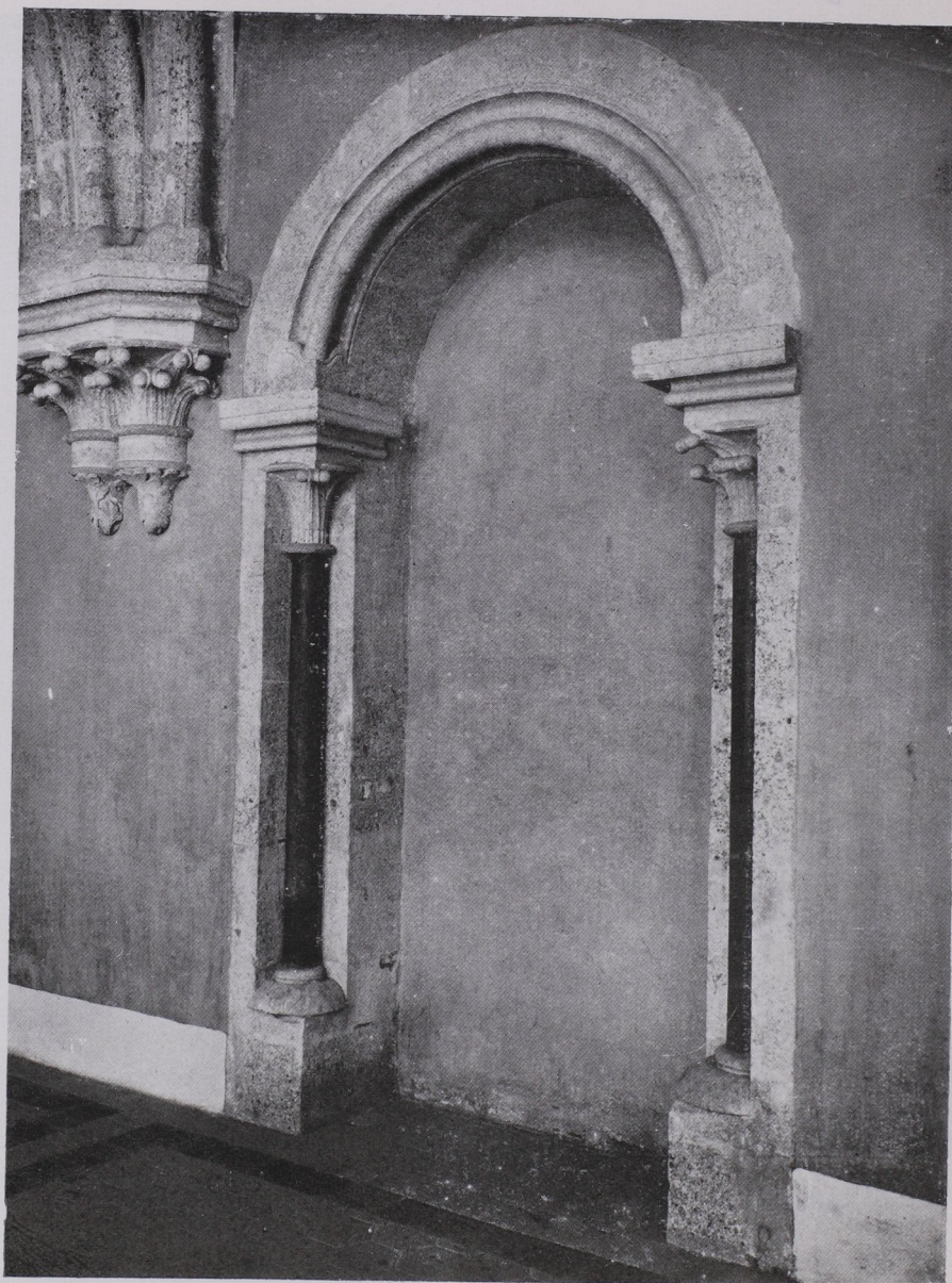
Abb. 94 Türe des ehemaligen Kalefactoriums (S. 151).
