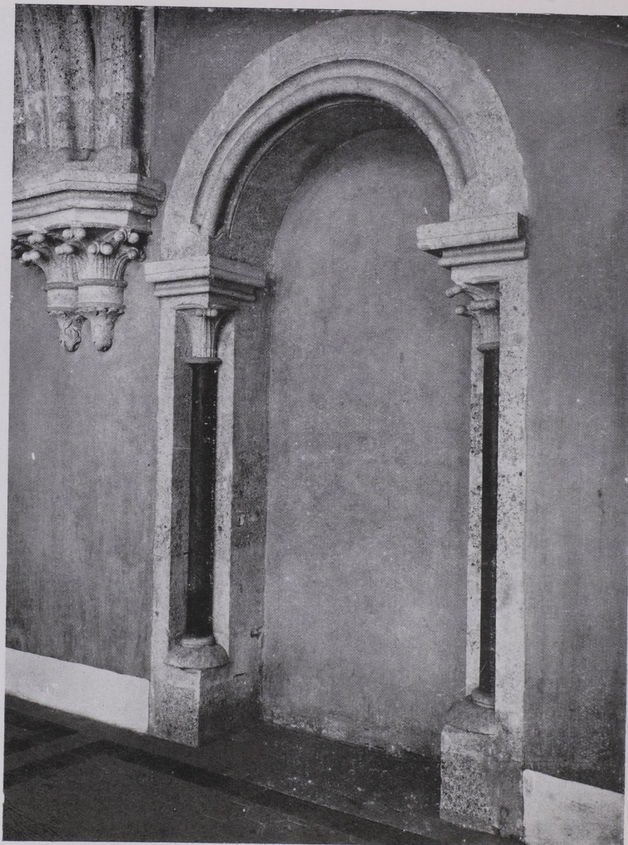
Abb. 94 Türe des ehemaligen Kalefactoriums (S. 151).
