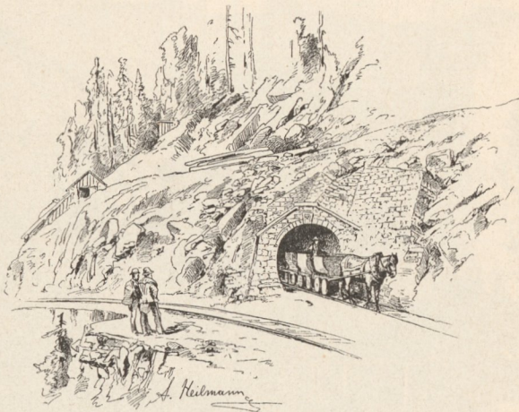
Zufahrtstollen zum IX. Bremsschachte auf der Dreikönig-Etage.
