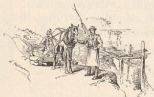
Bausteinförderung auf die Etagen.
