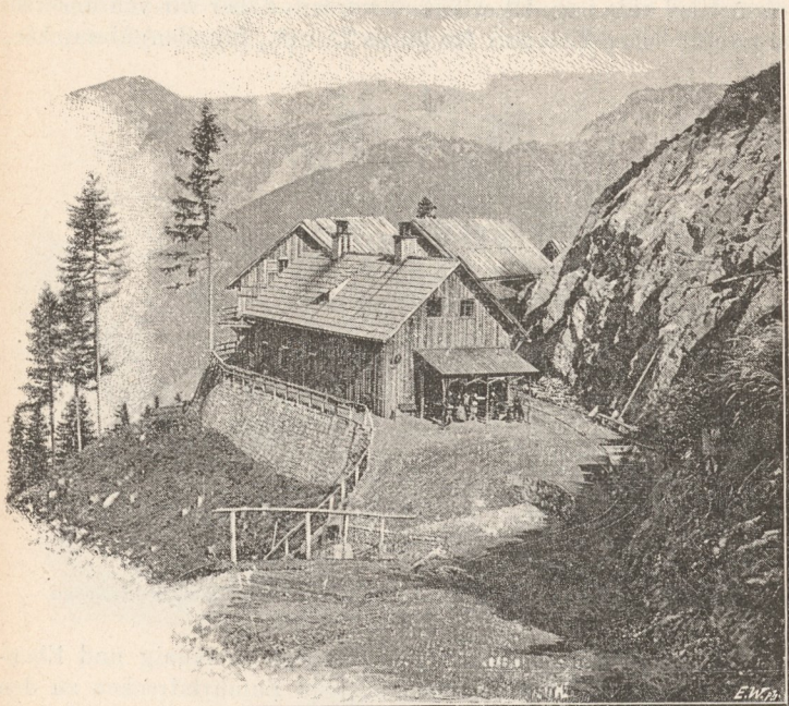
Arbeitercolonie auf der Dreikönig-Etage (1085 Meter ü. d. M.); im Vordergrunde die Cantine.
