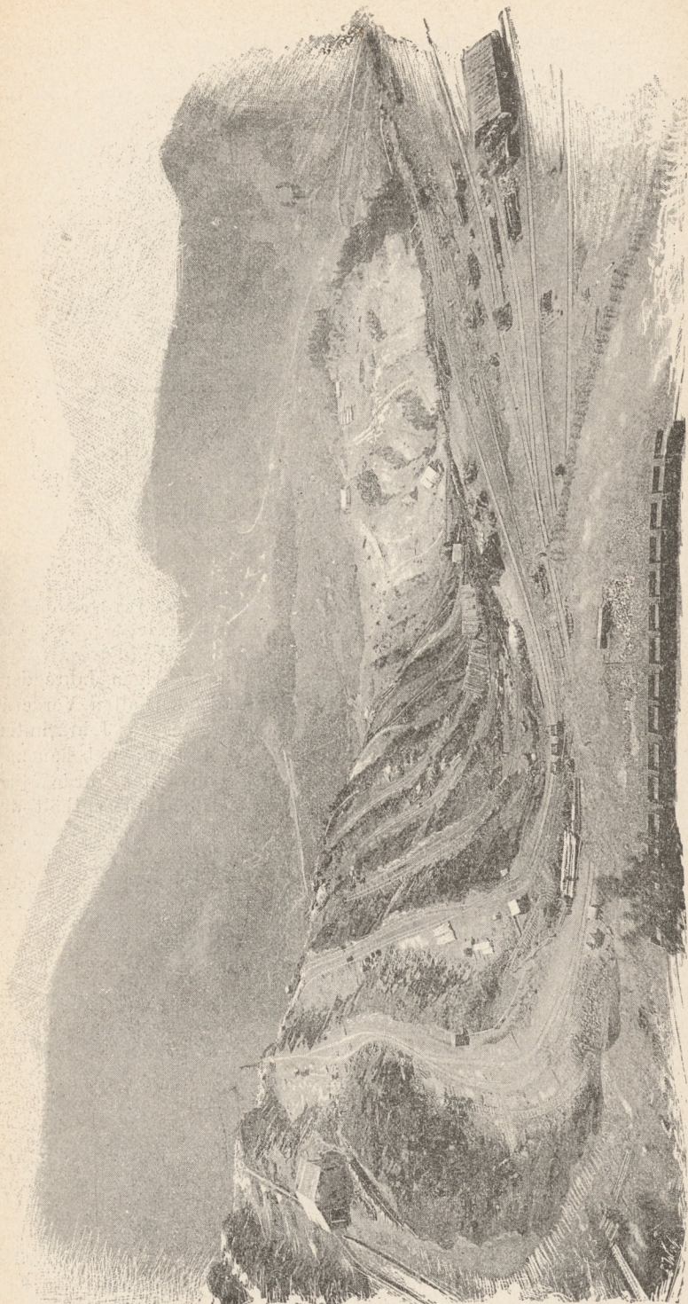
Ausblick von dem Balcone des alten Berghauses auf die Ebenhöhe und die unter derselben liegenden Etagen (Vogelperspective). — Auf der Ebenhöhe links der Abbremsschacht Nr. VIII zur Dreikönig-Etage. (Nach Photographien von C. Weighart in Leoben.)
