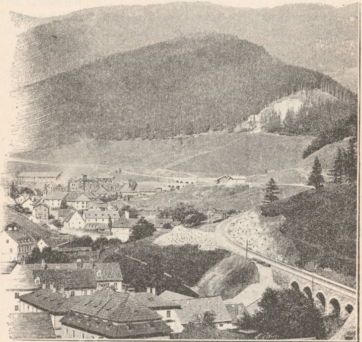
Station Vordernberg-Markt (844 Meter ü. d. M.) mit den beiden Viaducten über den Rötzgraben; im Vordergrunde der Rebenburg-Viaduct. (Nach Photographien von C. Weighart in Leoben.)
