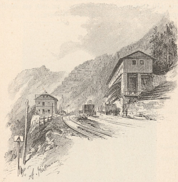
Station Erzberg mit Restauration (1070 Meter ü. d. M.) mit den Erzladerampen und Blick auf den Etagenbau des Erzberges der Oesterreichisch-Alpinen Montangesellschaft.
