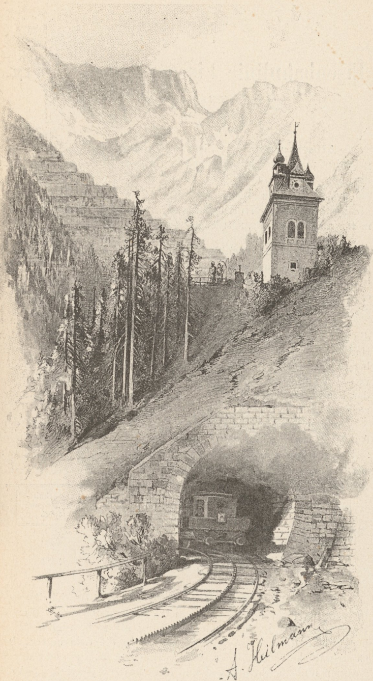
Der Schichtthurm-Tunnel nächst der Station Eisenerz; links im Vordergrund der Etagenbau am Erzberge in Sicht, im Hintergrunde die Reichenstein-Gruppe.
