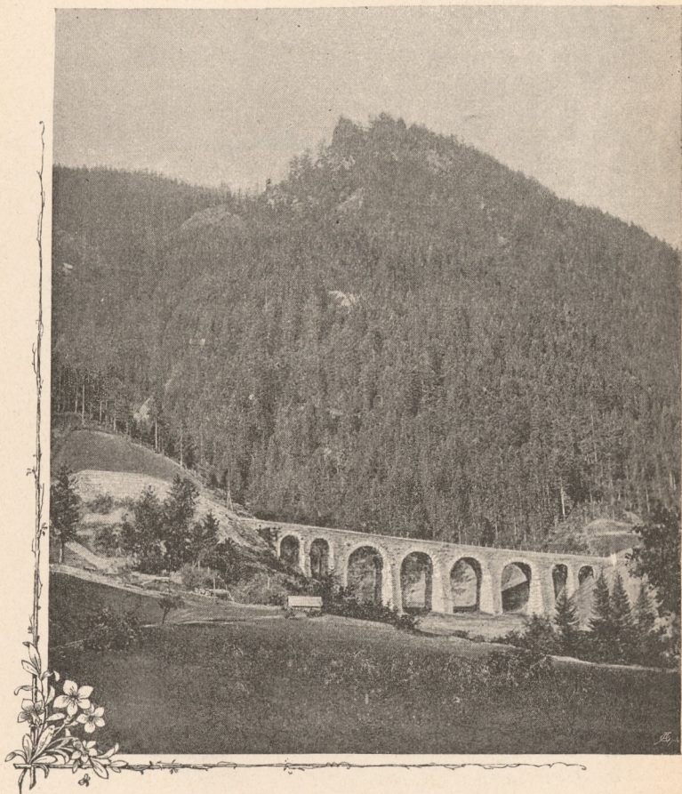
Sauerbrunngraben-Viaduct am Fusse des Kressenberges im Hintererzberggraben.
