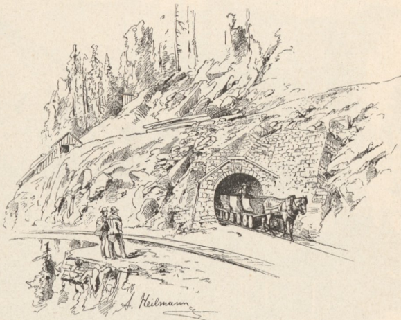
Zufahrtstollen zum IX. Bremsschachte auf der Dreikönig-Etage.
