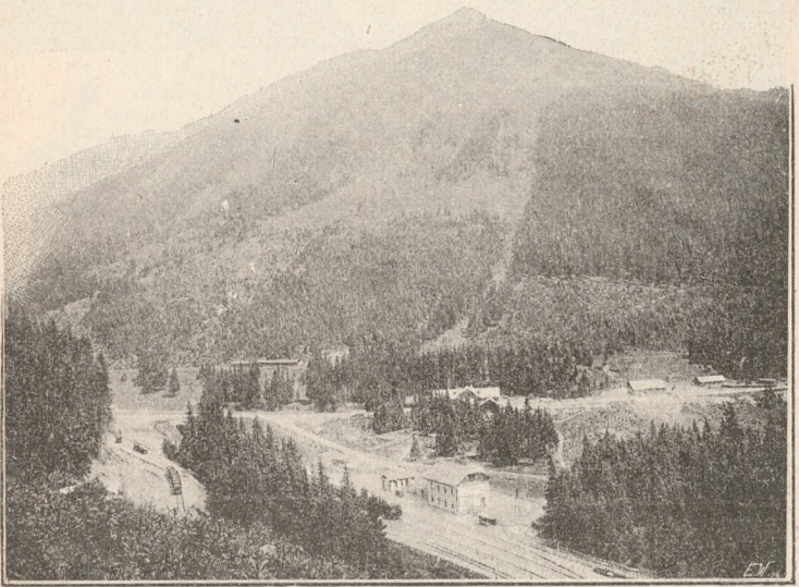
Station Präbichl (1204 Meter ü. d. M.)
