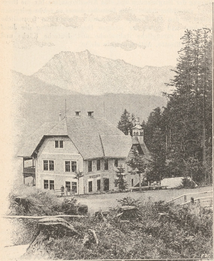
Das Barbarahaus (956 Meter ü d. M.), auch Eisenerzer Berghaus genannt.
