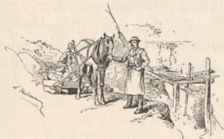
Bausteinförderung auf die Etagen.
