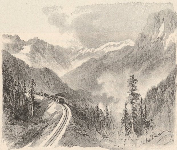
Ausblick ob dem Westportale des Präbichl-Tunnels vom Präbichl- Pass aus (Eisenerz zu).
