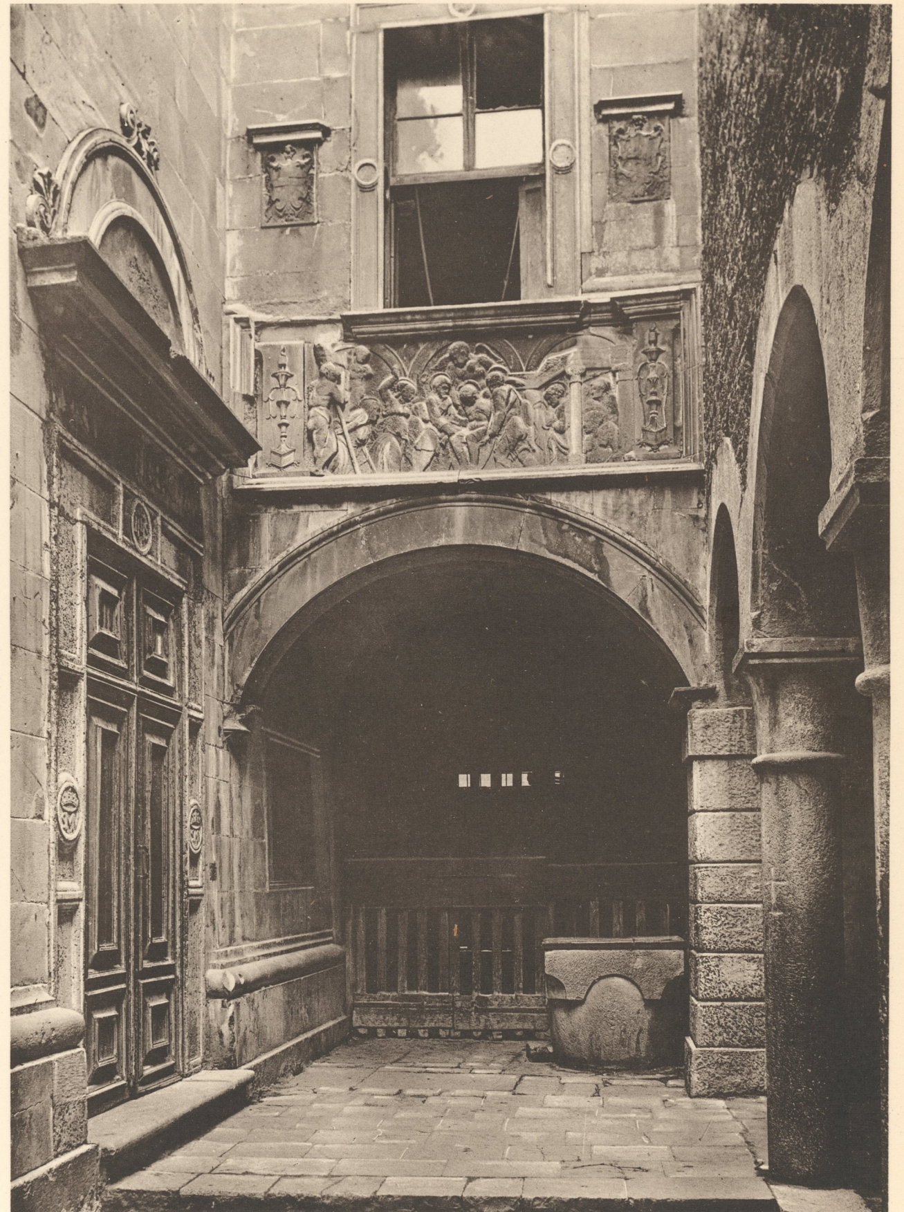
Sebenico. Links Gassenpartie gegen die grosse Cisterne, rechts Hof.
