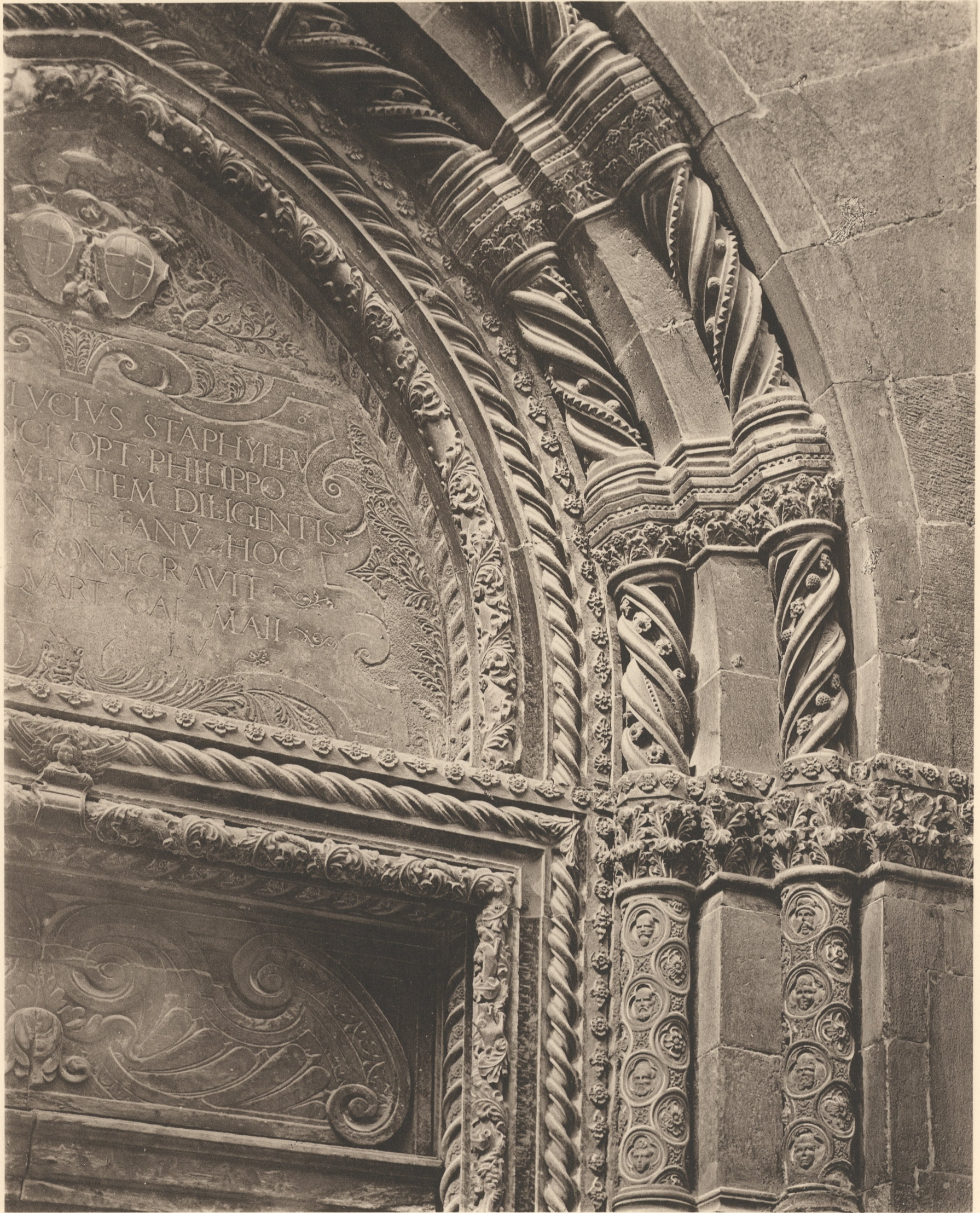
Sebenico. Dettagli del portale laterale.
