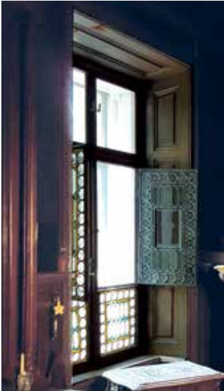
Abb.5: Bleiverglastes Fenster der Gründerzeit.
