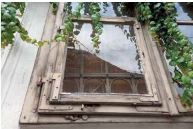
Abb.19: Restaurierfähiger Zustand eines Bestandsfensters an der barocken Fassade des ehem. Palais Hochenrain in der Grazer Kinkgasse. Die Instandsetzung konnte jüngst fertiggestellt werden.
