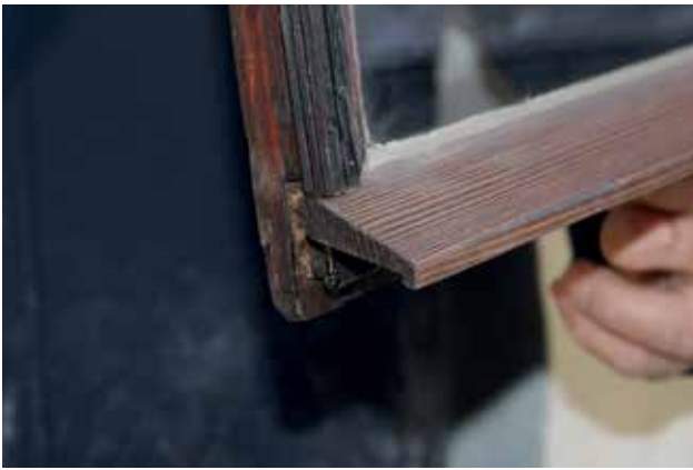
Abb.17: Erneuerter Wetterschenkel an einem historischen Fensterflügel im alten Konventhof von Stift Rein.
