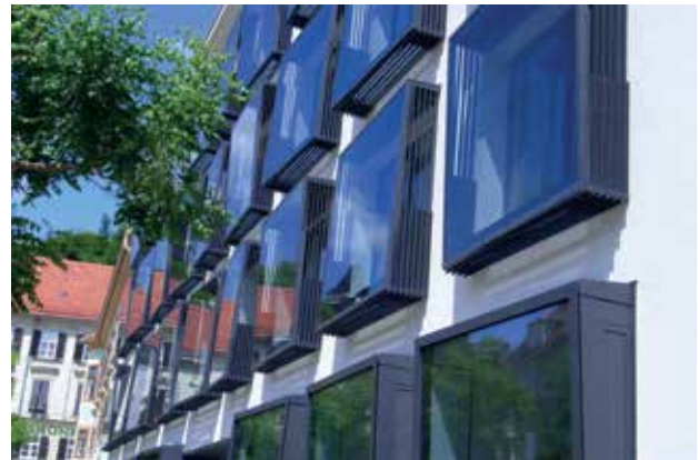
Abb.8: Das Kastenfensterprinzip in zeitgenössischer Form weiterentwickelt, Karmeliterhof.
