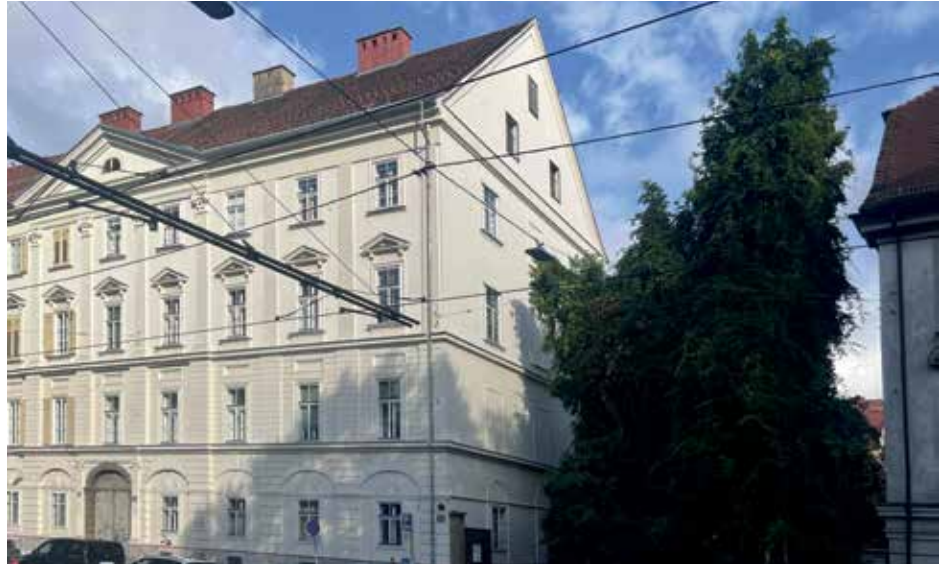
Abb.6: Gründerzeithaus Glacis mit Wiener Kastenstockfenster und Blendfenstern an der Schmalseite.
