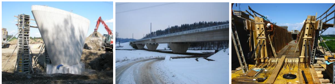
Abbildung 4 Spannbetonbrücke über die Kainach FW13, Fotocredit: Vill [4]
