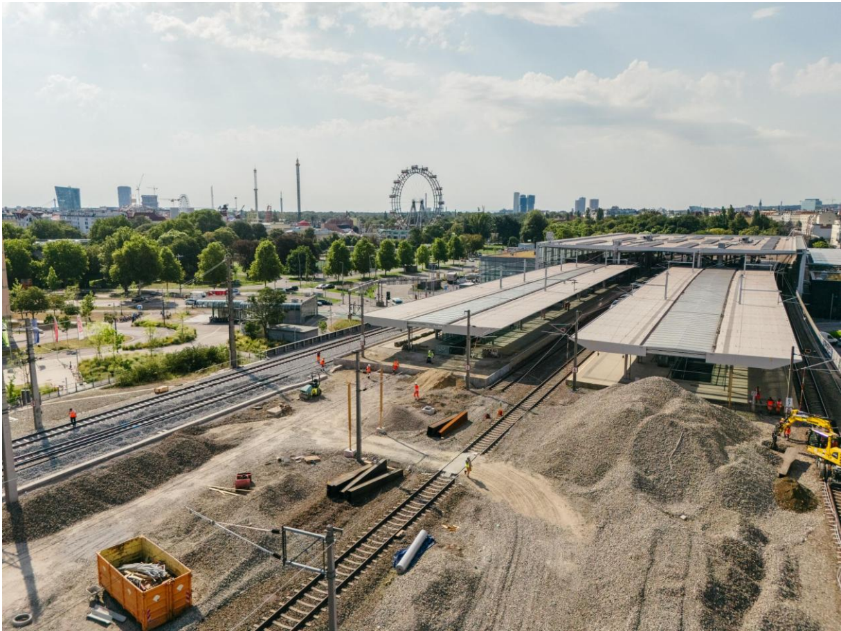
Abbildung 3 S-Bahn Upgrade Wien, Baustelle Praterstern (c) ÖBB_Lukas Leonte
