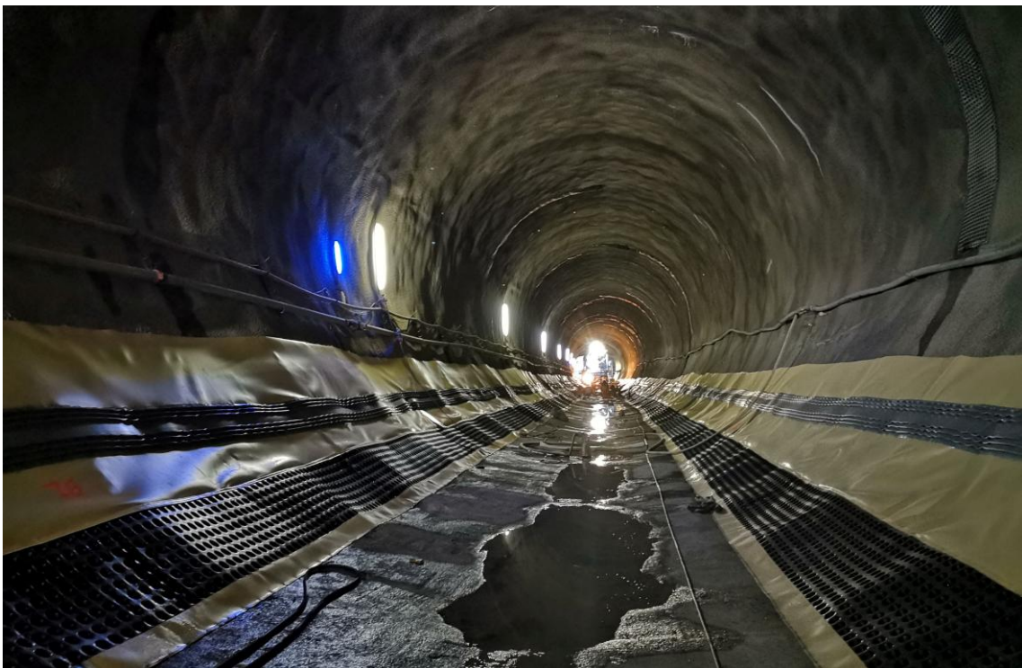
Abbildung 2 Längslaufende Noppenfolie als Alternative zu konventionellen Ulmendrainagen, Bauphase zyklischer Vortrieb Gleis 1, Baulos KAT3.
