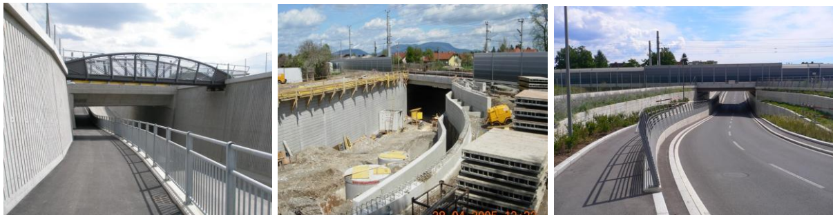
Abbildung 1 Diverse integrale Rahmenbauwerke Koralmbahn, Graz Klagenfurt, Fotocredit: Vill [1]
