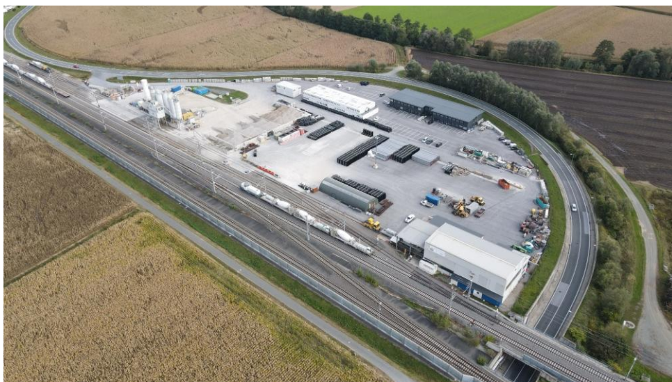
Abbildung 1 Luftbildaufnahme BE Ost mit einer Fläche von 25.000 m 2
