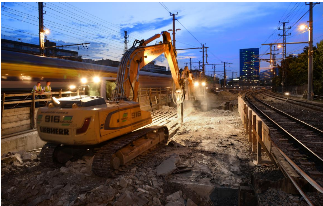
Abbildung 4 Bauen unter Betrieb; Abtrag Brücke Friedhofstraße Linz (c) ÖBB Robert Deopito
