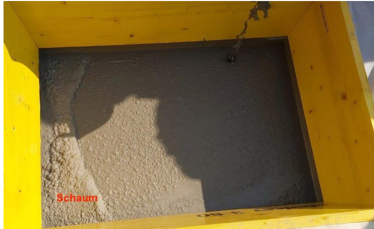
Abbildung 5 Schaumbildung am Frischbeton in der Einfüllöffnung
