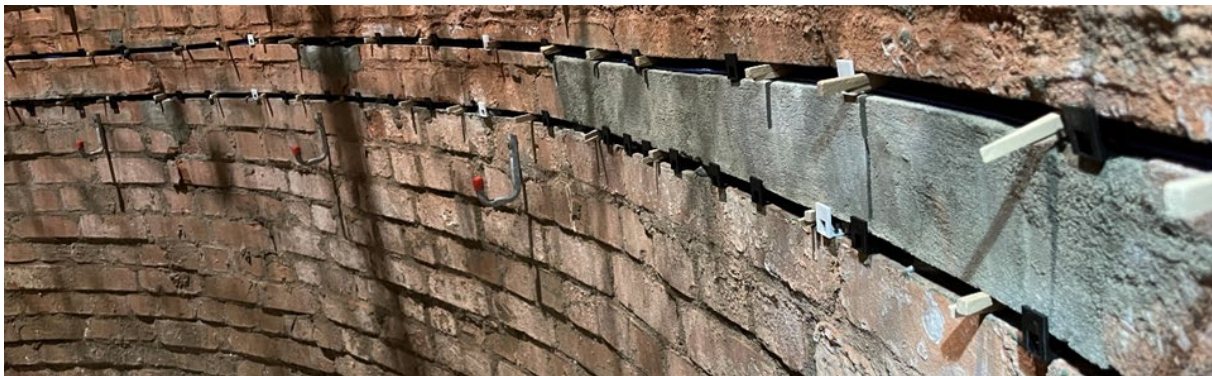
Abb. 5: Geschlitztes Schachtmauerwerk (oben Messhorizont 1, unten Messhorizont 2).
