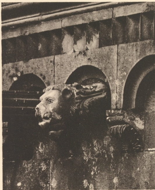
Die Domkirche. Details der Fassade.
