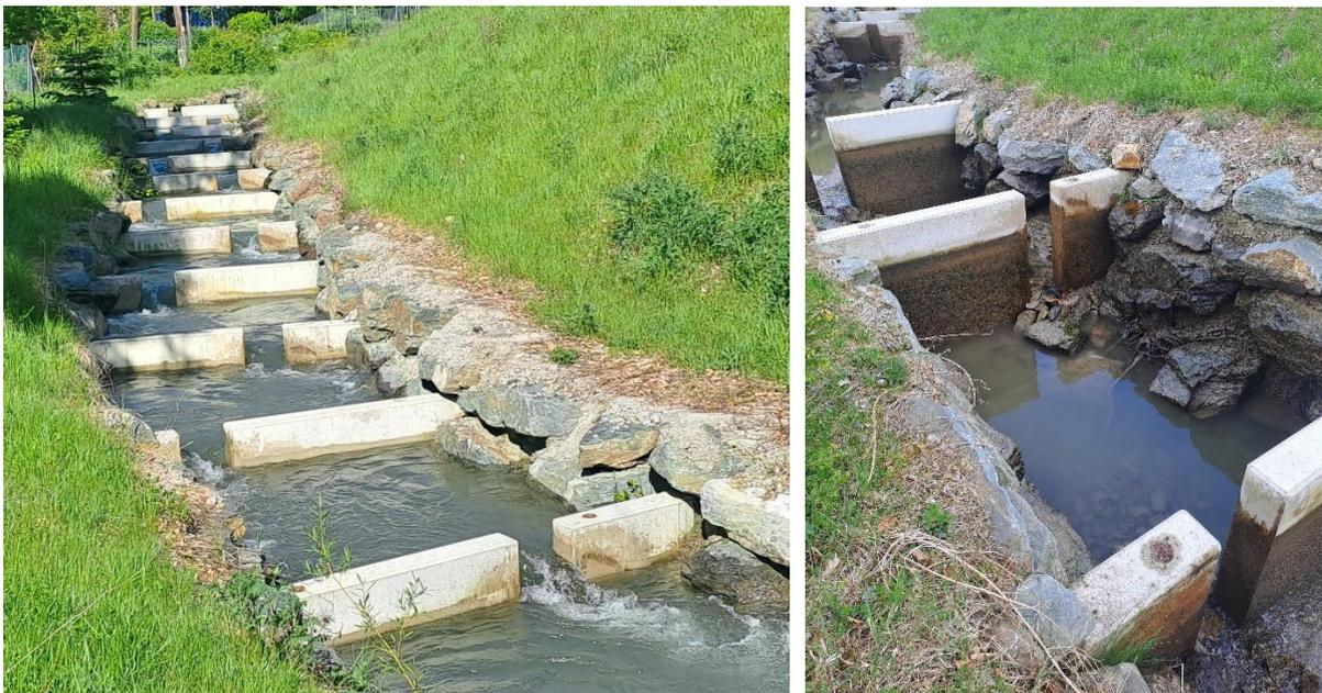
Abbildung 2: Technischer Beckenpass dotiert (li) und undotiert (re)
