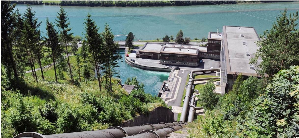
Abbildung 1: Standortansicht mit Krafthaus Rottau, Unterwasserbecken, Verteilrohrleitungen und unterem Ende der schrägliegenden Druckrohrleitungen.
