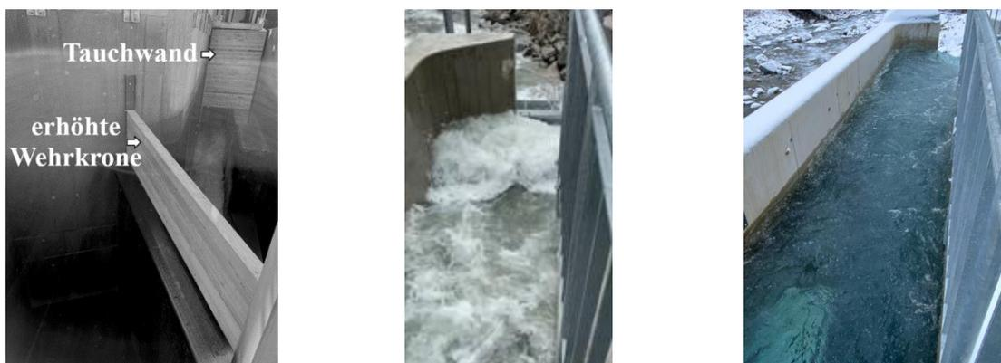
Abbildung 10: Umbaumaßnahme (links), Strömungssituation im Becken vor- und nachher
