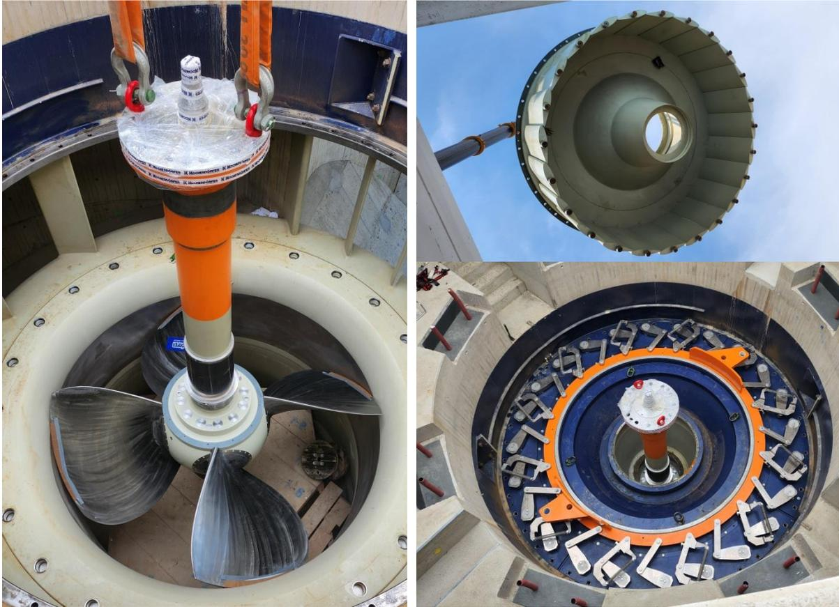
Abbildung 9: Links – Montage des 2. Läufers, rechts – Leitapparat in seiner Position
