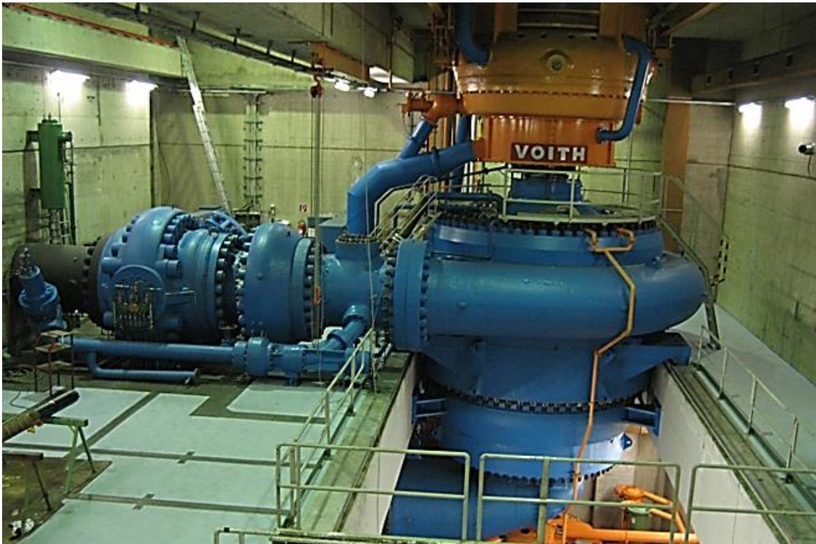
Abbildung 2: Bestehende Speicherpumpenkonfiguration mit Saugrohr, Pumpengehäuse und Spiralgehäuse, dargestellt zusammen mit Anfahrwandler, Stopfbuchse und Kugelschieber.
