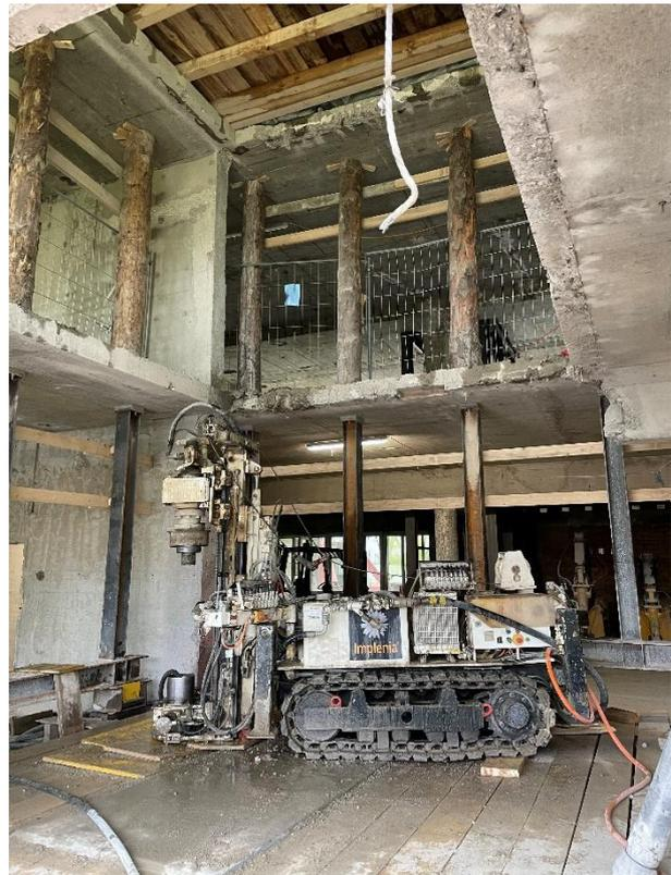
Abbildung 7 Mikropfahlbohrgerät Treppenhaus, Bohrplanum auf Plattform im EG (© LM)
