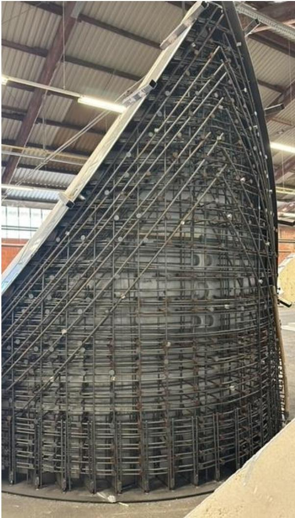
**Abbildung 6** Schließwand mit Bewehrung und Einbauteilen
