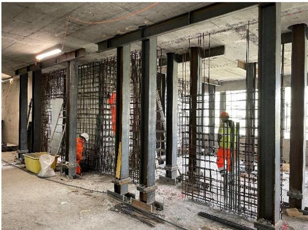
Abbildung 11 Ausführung Abfangscheiben über Eingangshalle (© LM)
