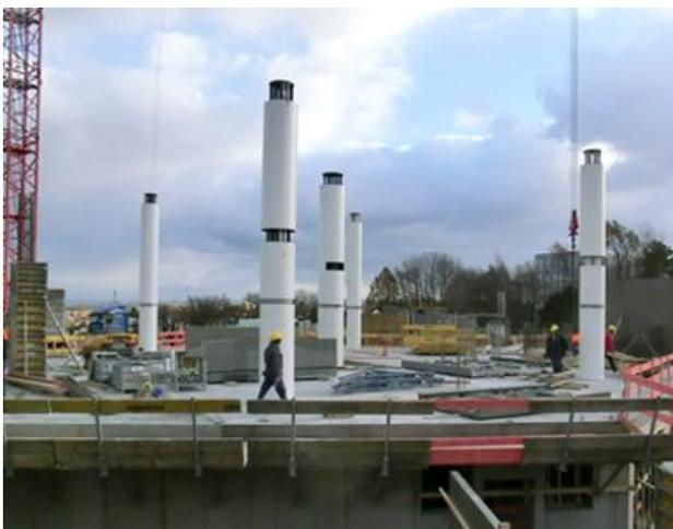
Abbildung 3 Stützenmontage und Ebene E1/E2 mit zweigeschossigem Eingangsbereich
