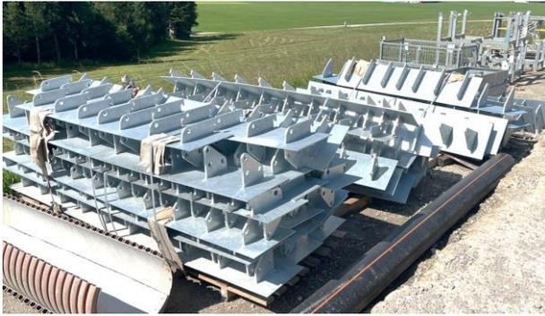
**Abbildung 8** Stahltrennblech (vertikale Trennbleche mit 3,00m Länge samt den durchgesteckten und dicht verschweißten Stahlschwertern)
