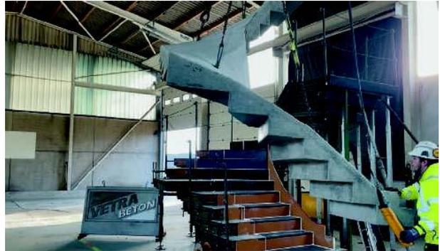
**Abbildung 5 Abheben der CO<sub>2</sub>-reduzierten Betonfertigteiltreppe**
