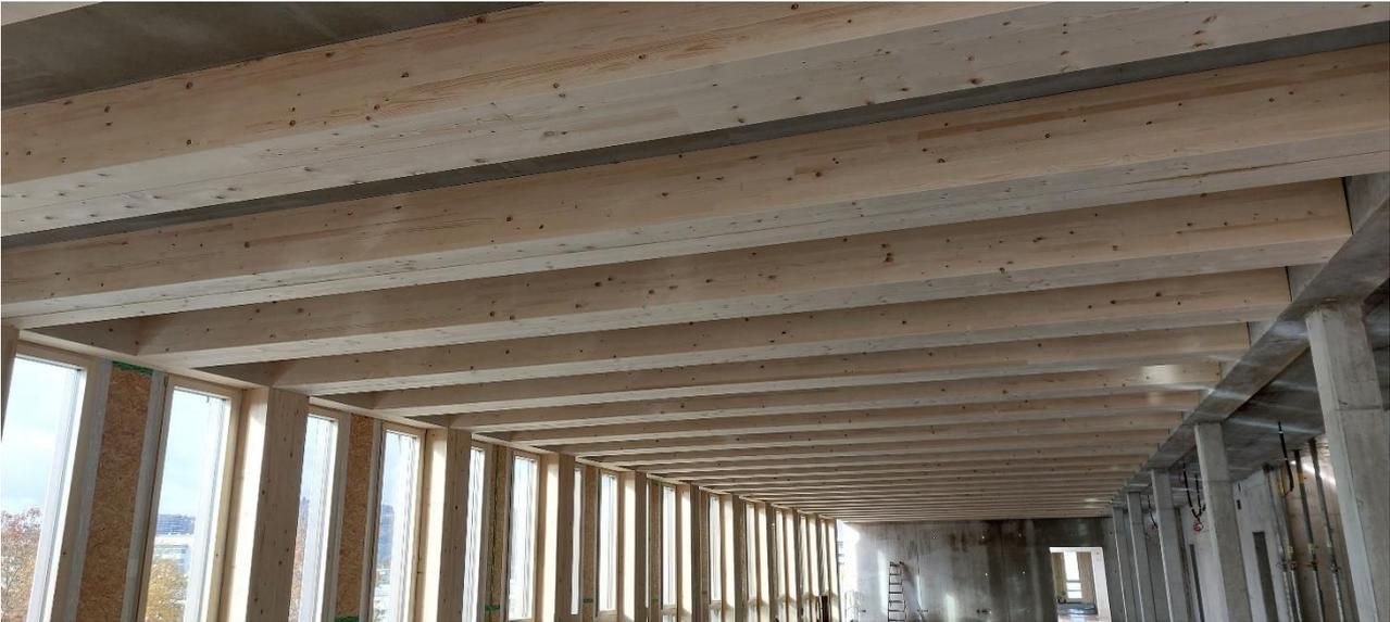
**Abbildung 14** Eigebaute HBV-Decke
