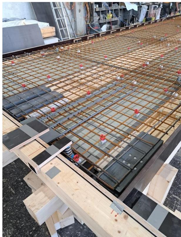
Abbildung 8 Auflager-Stahlplatten in Schalung vor Betonage
