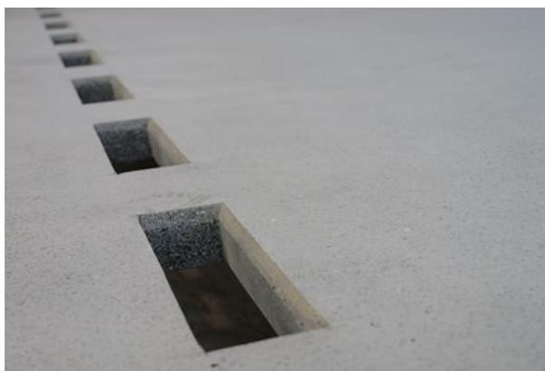
Abbildung 6 CPC Brückenplatte, Quelle CPC AG
