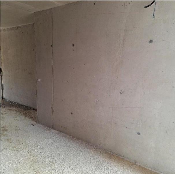
**Abbildung 3** Tragende Wand des Mehrfamilienwohnhauses, aus Beton, hergestellt mit ECOPlanet RC.
