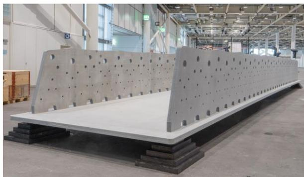
Abbildung 4 CPC Trogbrücke 17x3m, Quelle CPC AG
