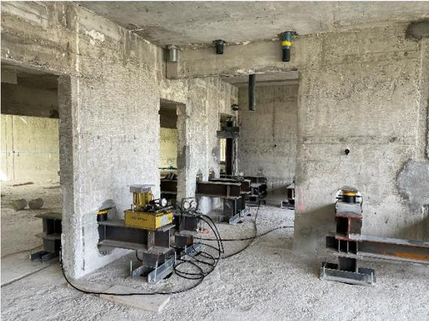
**Abbildung 7** Notsprießung mit hydraulischen Pressen
