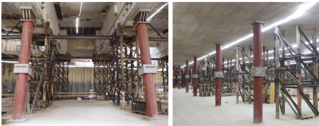
**Abbildung 11 Ausführung der Verbundstützen in der Ebene E-01/-02 und Ebene -03/-04**
