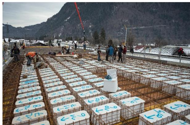
Abbildung 18 Eingebachte Aussparungskörper mit konventionell verlegter Bewehrung, © Concrete 3D\_Tomaselli Gabriel Bau
