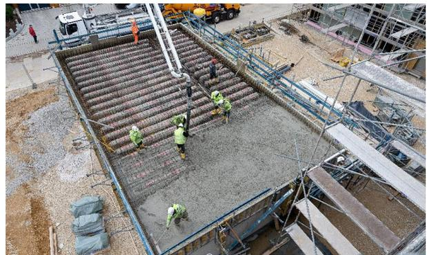
**Abbildung 16** Eingebroughte Aussparungskörper mit konventionell verlegter Bewehrung während der Betonage © Studio Herzig/EIGNER Bauunternehmung
