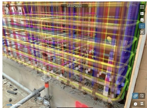
Abbildung 5 Vergleich des Soll-Zustandes mit dem Ist-Zustand bei einem Wandanschluss
