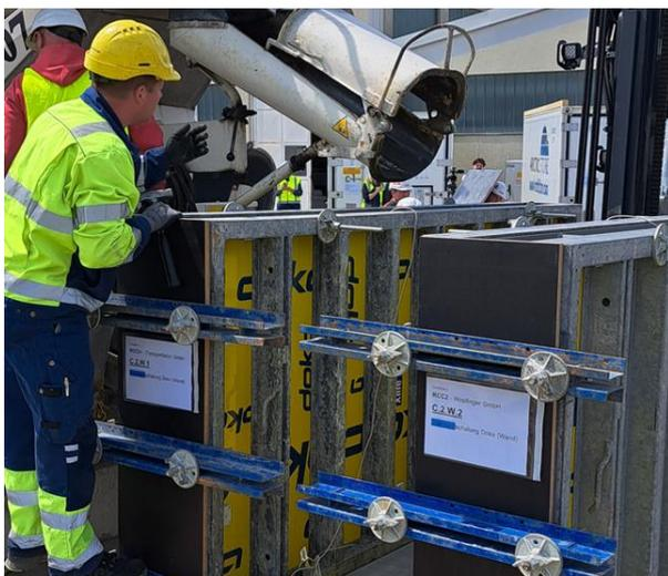
Abbildung 6 Herstellen der Versuchsbauteile am Gelände der Mischek Systembau mit Kühlcontainern im Hintergrund, 2023
