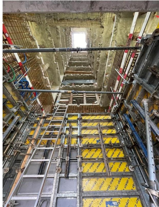
Abbildung 5 Neubau Treppenhaus, Logistik mit Kranöffnung (© LM)
