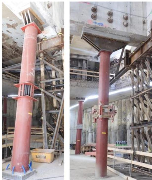
Abbildung 8 Verbundstützen in der Ebene E-01/E-02
