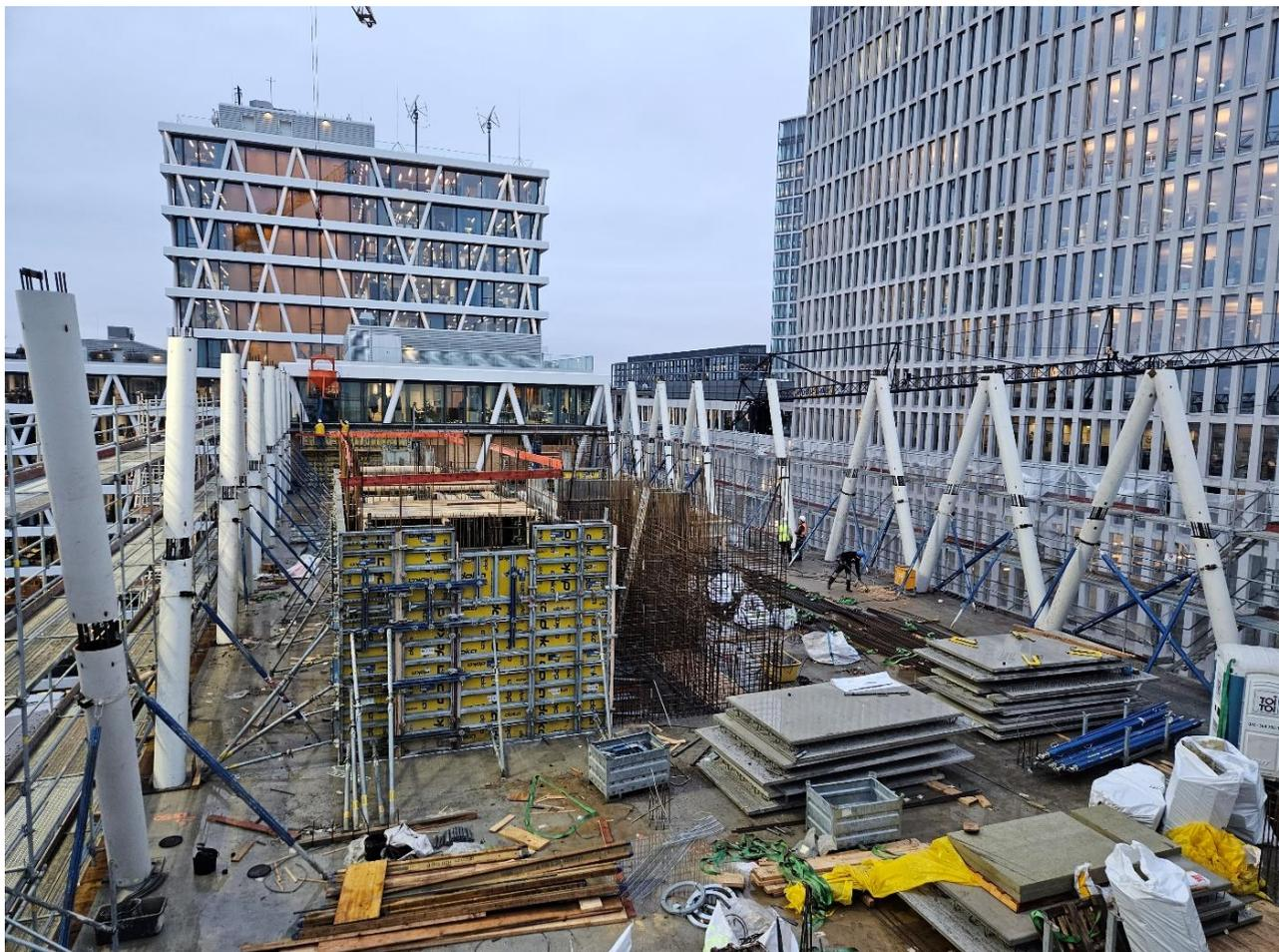
Abbildung 14 Stützenmontage 5. – 6.OG mit zweigeschossigen Stützen
