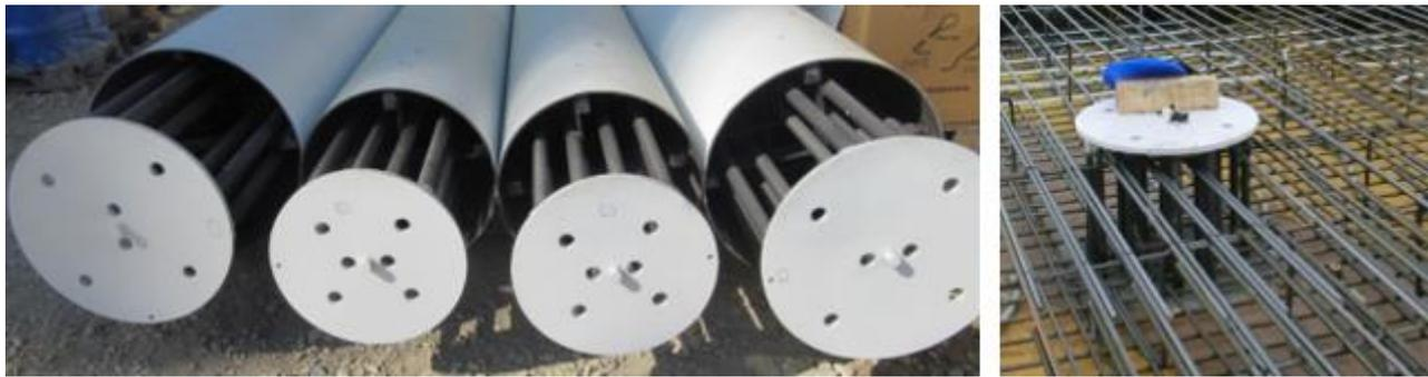
Abbildung 6 Verbundstützen mit Bewehrung im orthogonalen Raster als vorgefertigte Bauteile, Stützenkopf mit Deckenbewehrung
