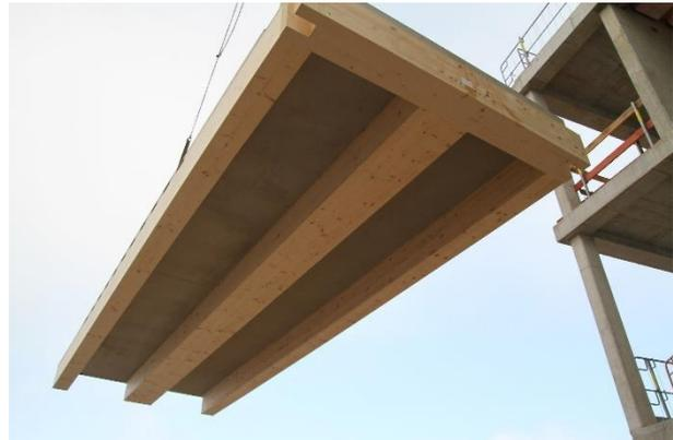
Abbildung 13 Montage einer Regelplatte
