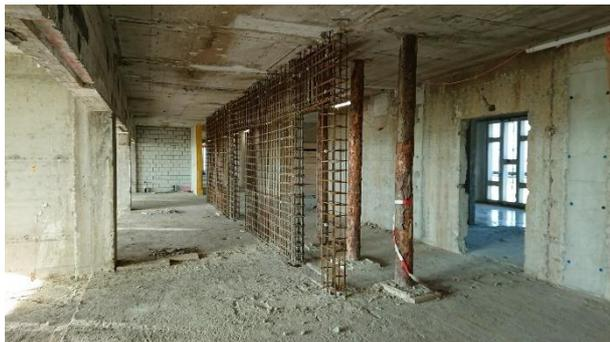
Abbildung 6 Bewehrung Längsmittelwand (© LM)
