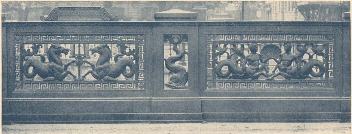
Abb. 269. Gitter der Schloßbrücke in Berlin.
