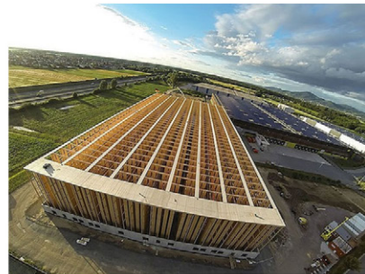
Abb.: Weltweit größtes Hochregal aus Holz: Alnatura mit Swisslog, BJ 2014 (Quelle: https://www.holzkuierer.com/holzbau/2014/05/groesstes_holz-hochregallagereroeffnet.html )
