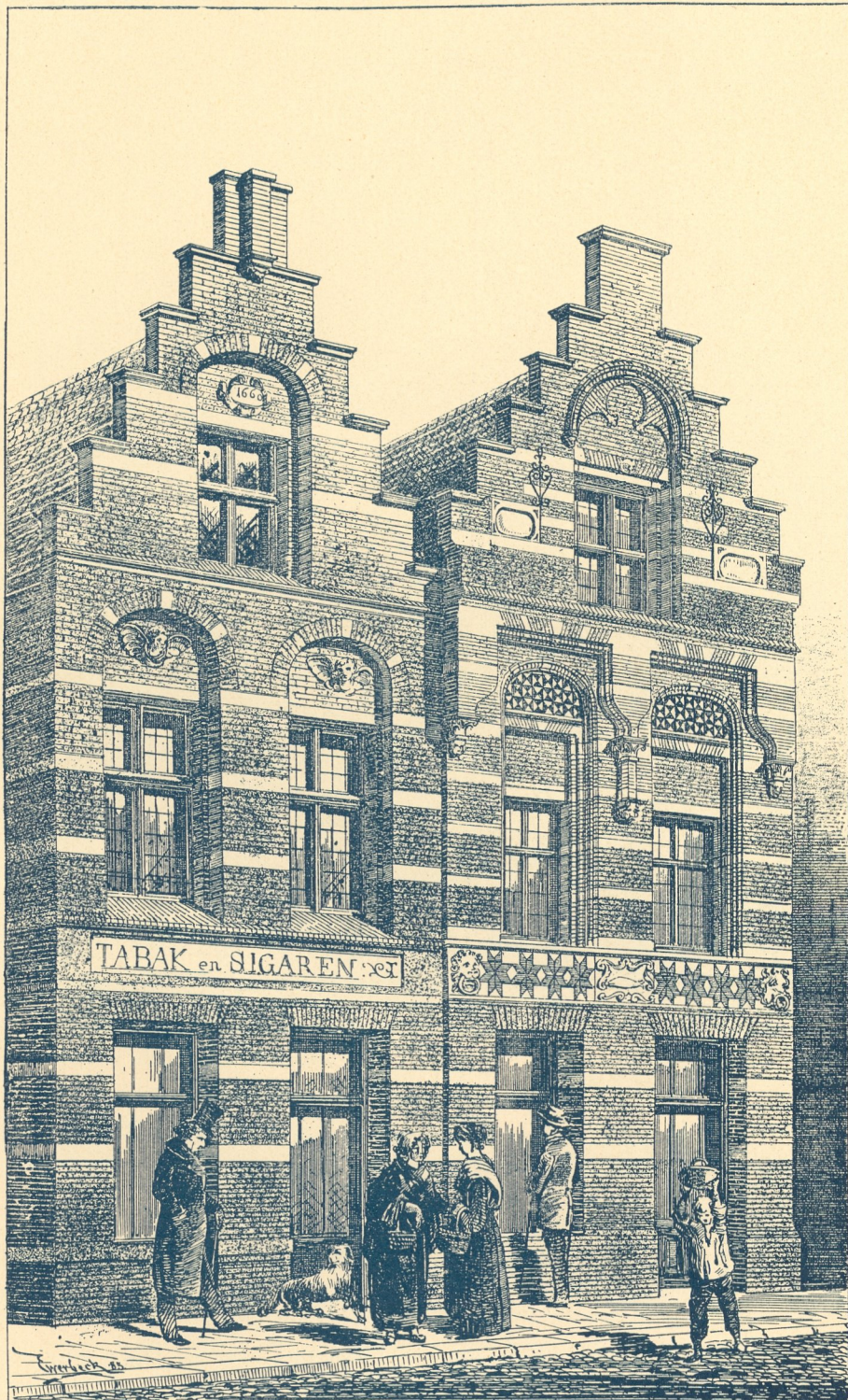
Fig. 77. Backsteinhäuser in Dordrecht. Nach Everbeck, Renaissance.
