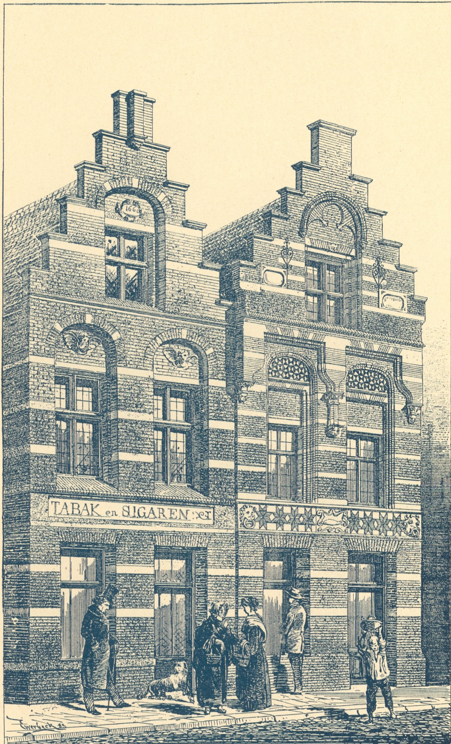
Fig. 77. Backsteinhäuser in Dordrecht. Nach Everbeck, Renaissance.
