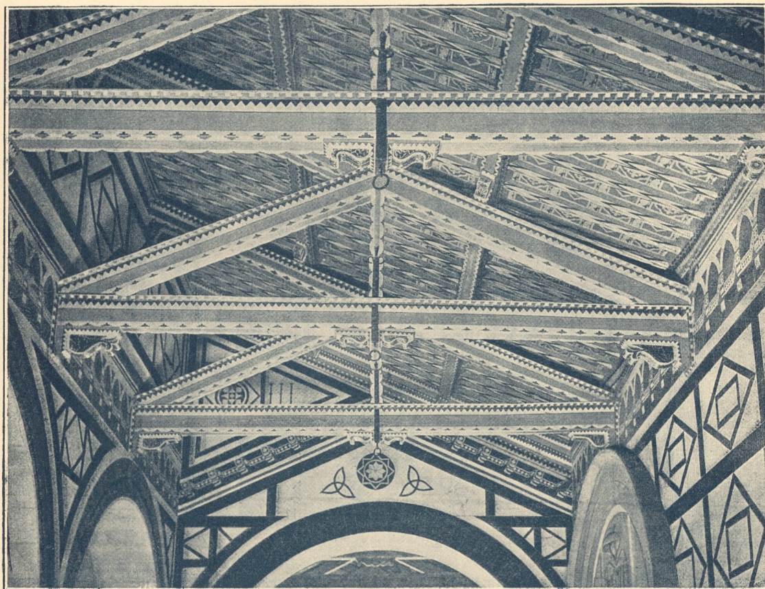
Fig. 90. Florenz (Chiesa di S. Miniato) Intravatura del soffitto.
