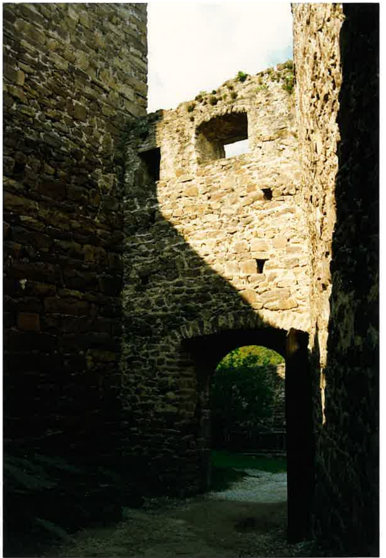
42 Hocheppan, Zwinger, Innenseite des Tores zur Vorburg
