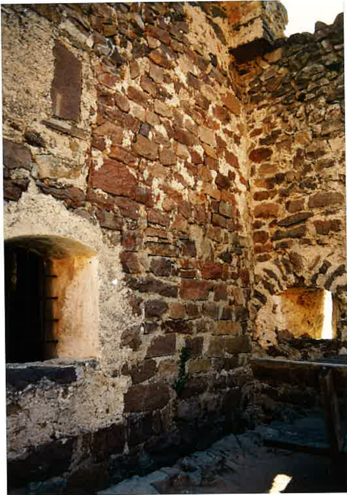
119 Hocheppan, Kapelle. Westseite mit anstoßender Mauer
