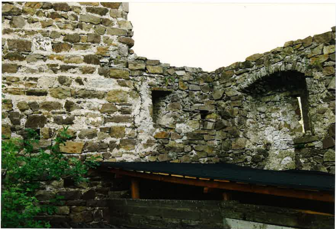
14a Hocheppan, südwestliche Ecke der Vorburg
