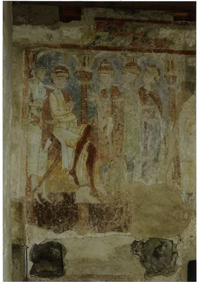
122 Hocheppan, Kapelle, Balkenlöcher in der Nordwand
