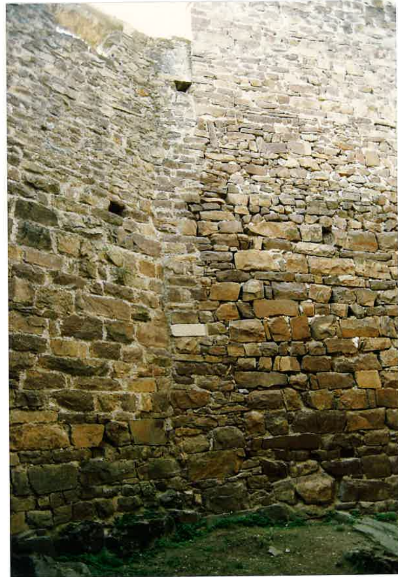
37 Hocheppan, Bergfried und östlich anschließende Mauer, vom Zwinger aus
