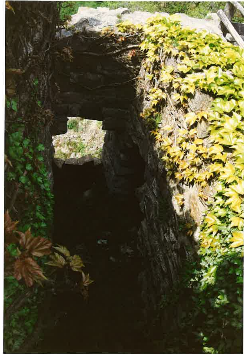
34 Hocheppan, Fluchtkorridor nach Westen
