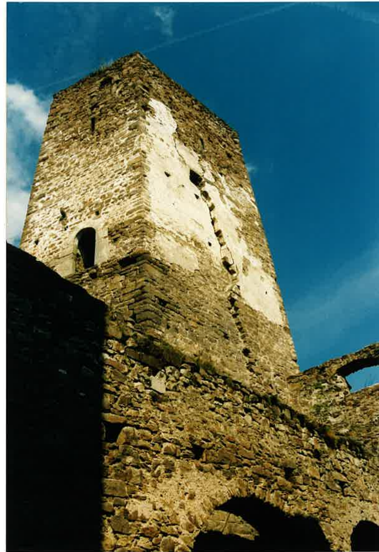
36 Hocheppan, Bergfried von Süd- osten
