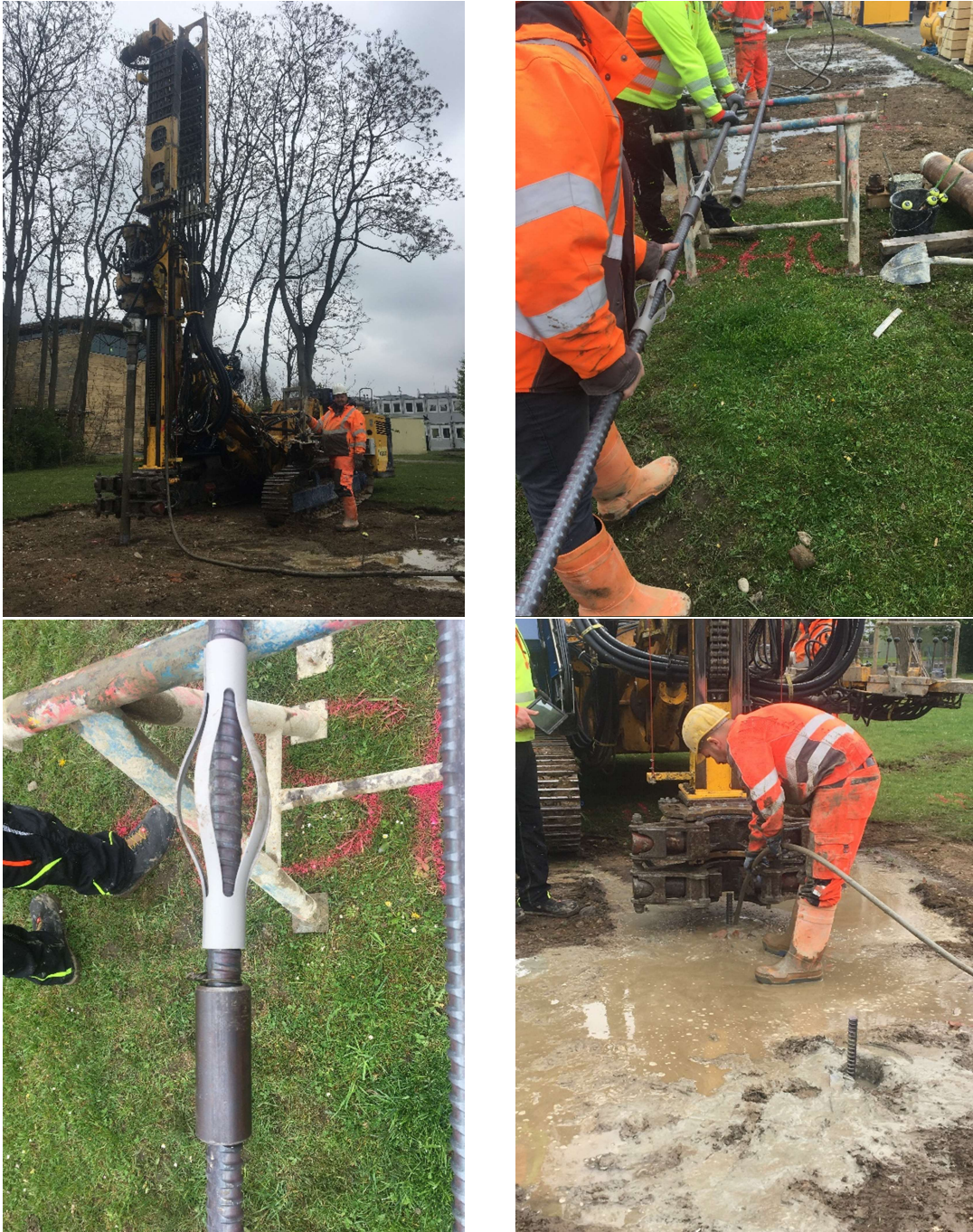
Abb. 29: Bilder der Herstellung der Probe-Mikropfähle; Bohrgerät Klemm (oben links); Zusammenbau Mikropfahl (oben rechts); Muffenverbindung (unten links); Verfüllen des Bohrloches mit Zementsuspension (unten rechts)
