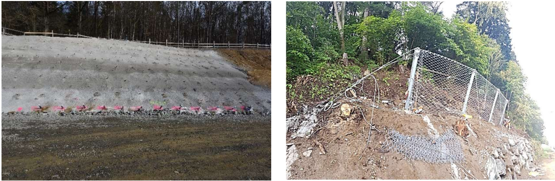
Abb. 7: Bodenvernagelung (links), Mikropfähle als Fundierung eines Steinschlag-schutzbauwerkes (rechts)
