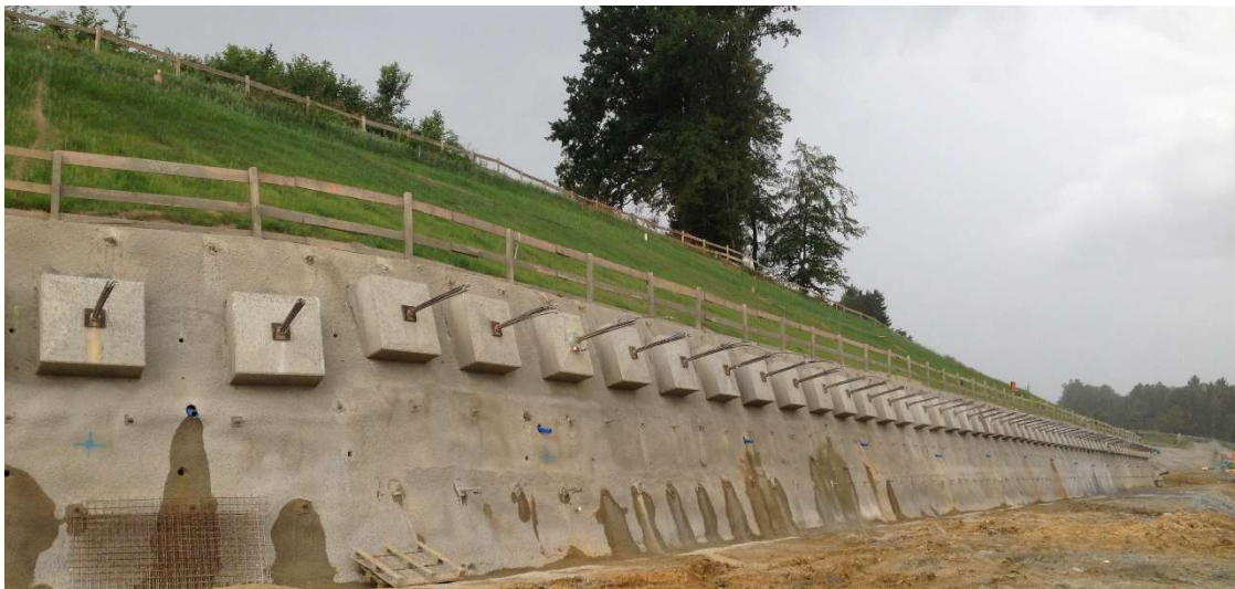
Abb. 6: Sicherung eines Hanganschnittes mittels Anker und Bodenvernagelung
