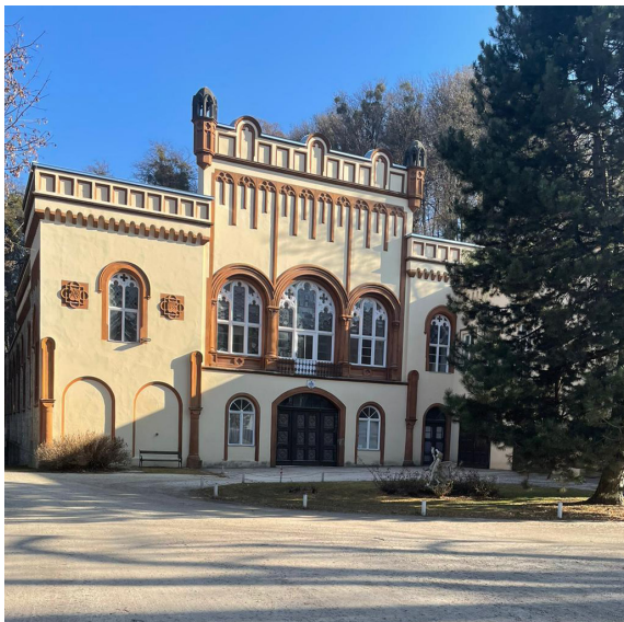
Abbildung 50: Ansicht Süd-West vom Vorplatz aus
