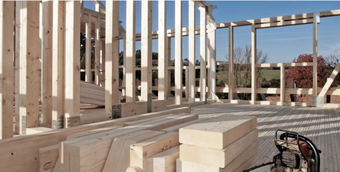
Abb. 48 Baustellensituation eines Rahmenbaus
