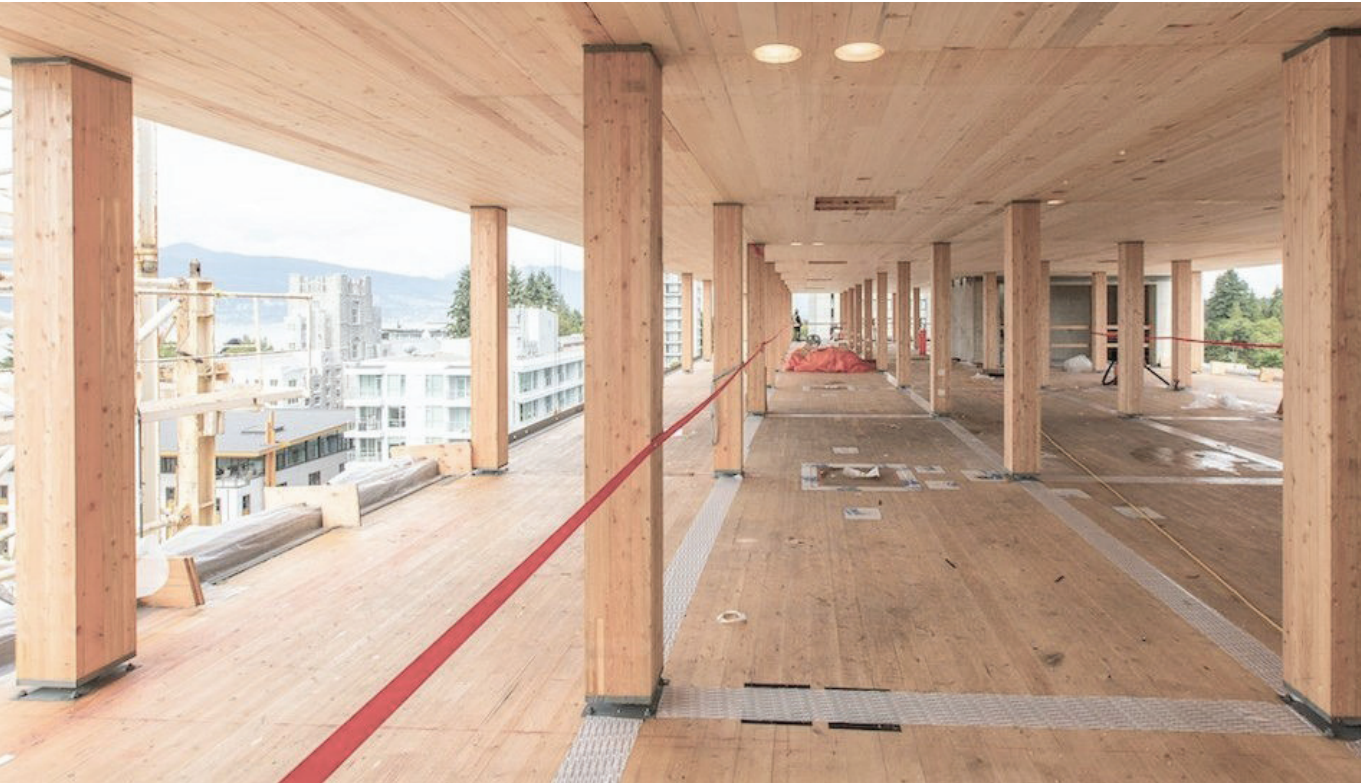
Abb. 52 Rohbausituation eines Holzskelettbaus
