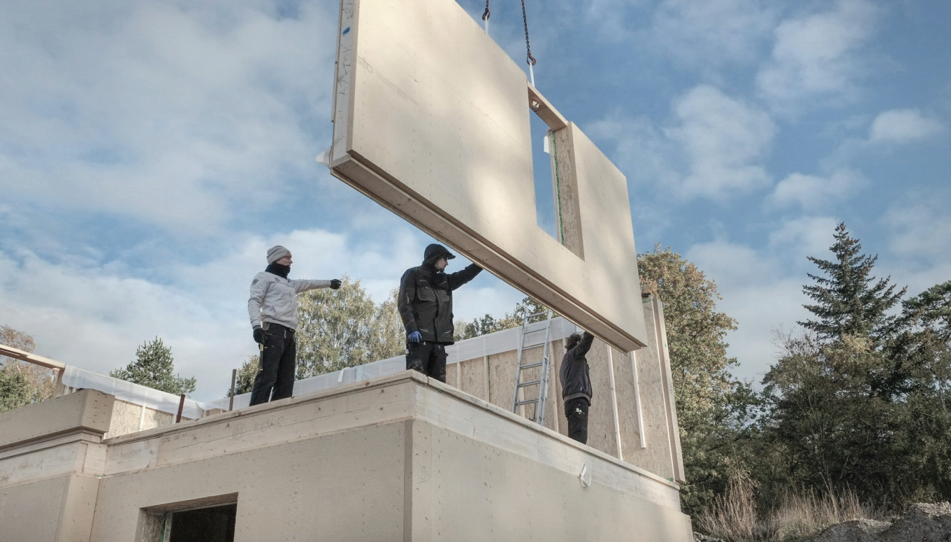
Abb. 50 Transport und Montage einer Tafelbauwand
