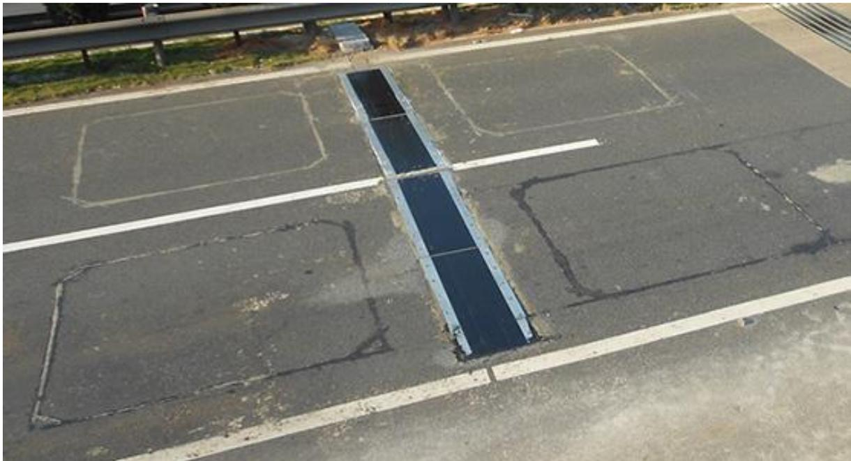
**Abbildung 10: In Fahrbahn verbauter Weigh-in-Motion-Sensor mit gummiartigen Biegeplatten
