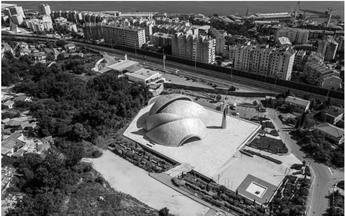
Abb. 82: Luftaufnahme des Islamischen Kulturzentrums in Rijeka, Kroatien, 2013.
