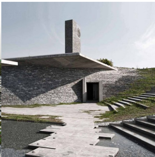
Abb. 74: Ansicht der Sancaklar Moschee mit Blick auf den Eingang und das Minarett, Istanbul, 2012.
