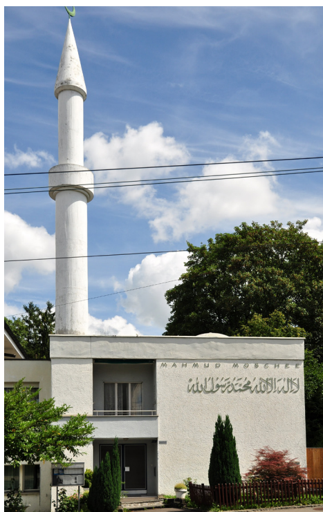
Abb. 49: Minarett der Moschee der Ahmadiyya-Gemeinschaft in der Forchstrasse, Zürich, 1966.
