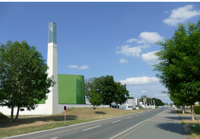
Abb. 63: Südwestansicht des Islamischen Kulturzentrums in der Laubgasse, Graz.
