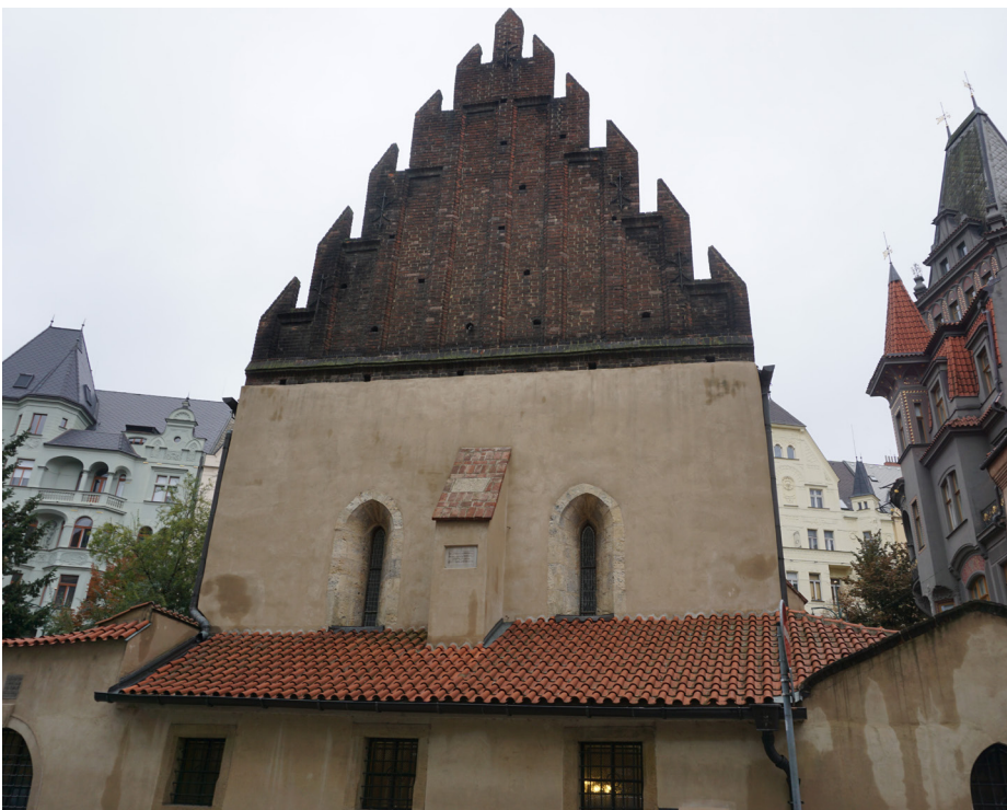
24 Abbildung 24: Westwand Altneuschul, Prag
