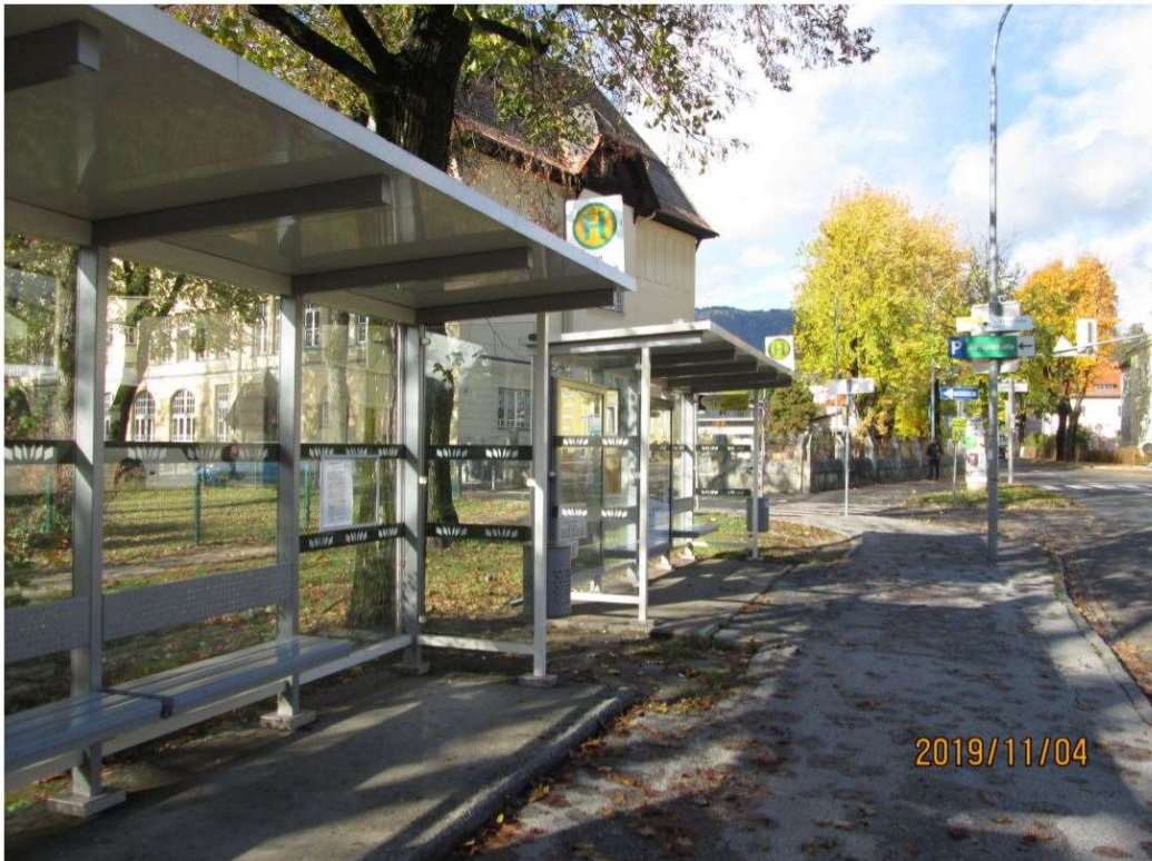
Abbildung 16: Bushaltestelle Villach Lind Schulzentrum 20
