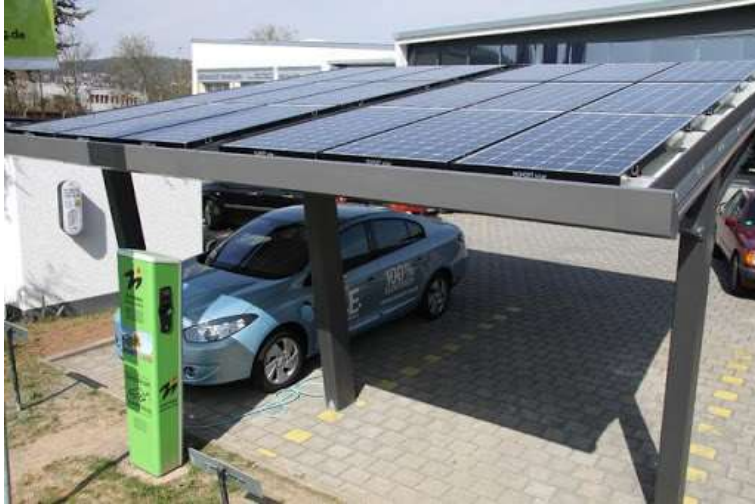
Abbildung 173: Beispiel Carport mit PV-Anlage und Tanksäule für E-PKW 61
