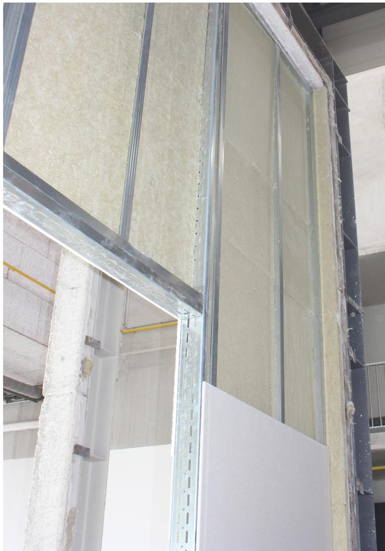
Abbildung 2.6: Im Aufbau befindliche Leichtbauwand mit begonnener Gipskartonverkleidung
