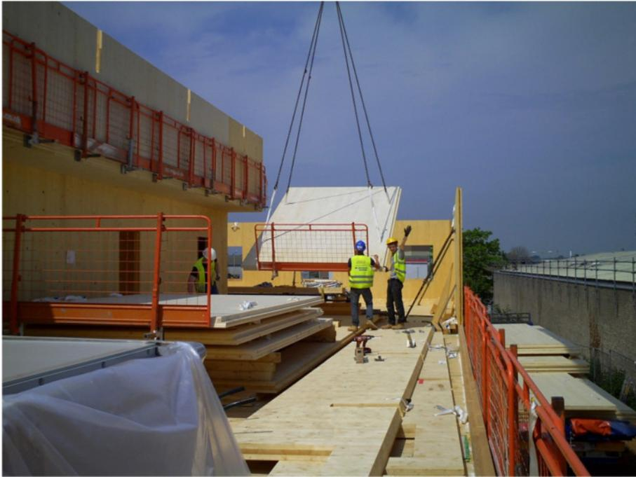
Bild 3.16 Einheben der Dachplatten
