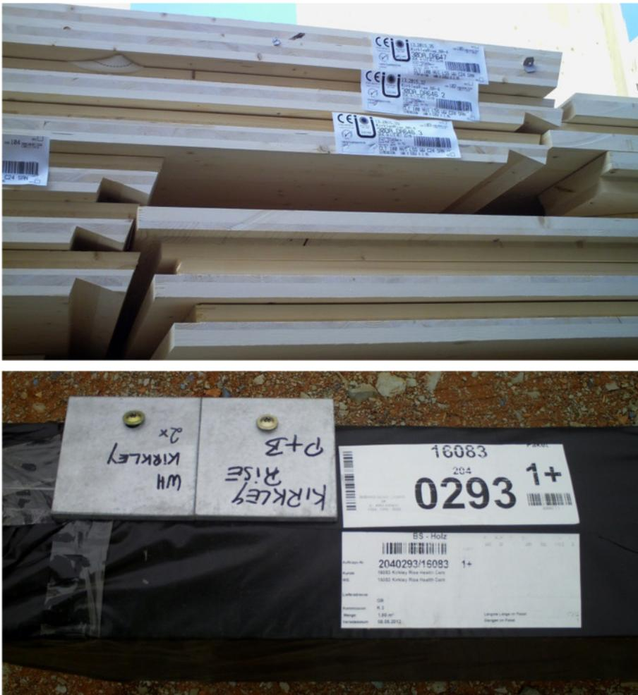
Bild 2.22 Aufkleber und Paketzettel auf gelieferten Bauteilen
