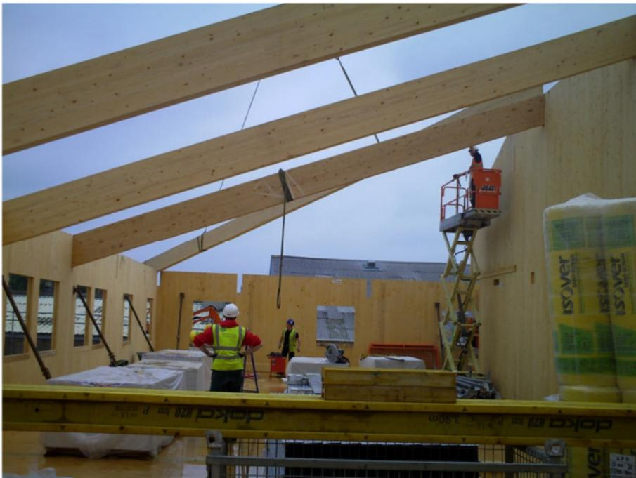
Bild 3.15 Montage der Dachträger
