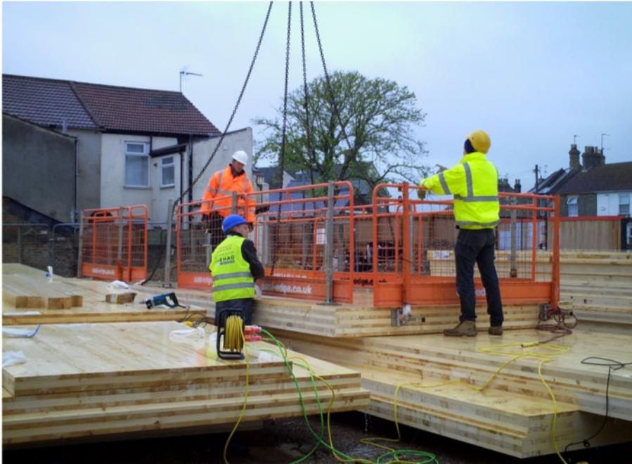
Bild 3.9 Vormontage des sog. Easi-Edge an den Rändern der Deckenplatten
