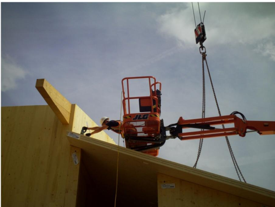
Bild 3.14 Montage des Daches über EG
