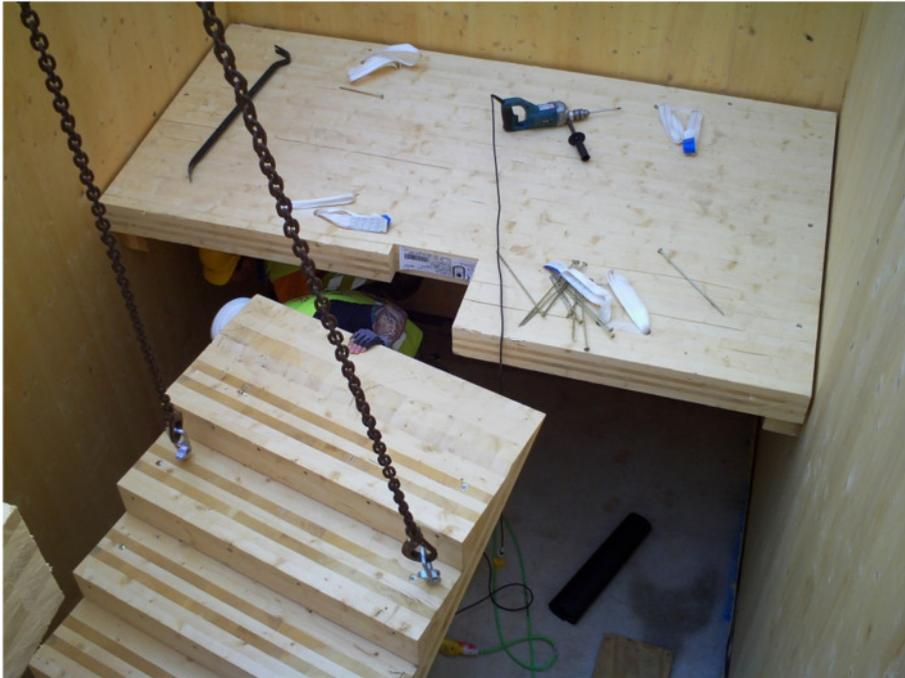
Bild 3.11 Montage der Treppenelemente
