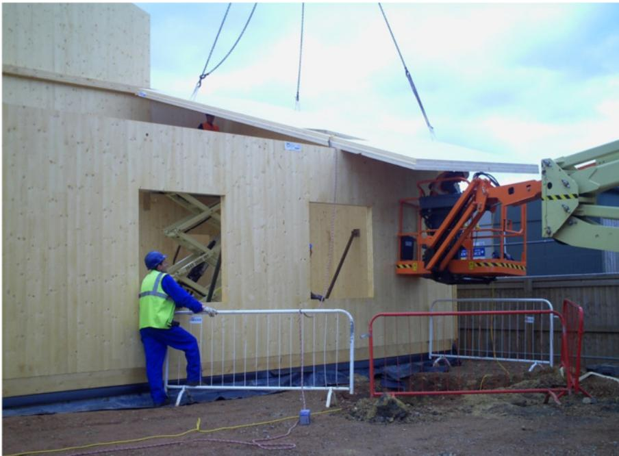
Bild 3.13 Verlegen Dachplatten über EG
