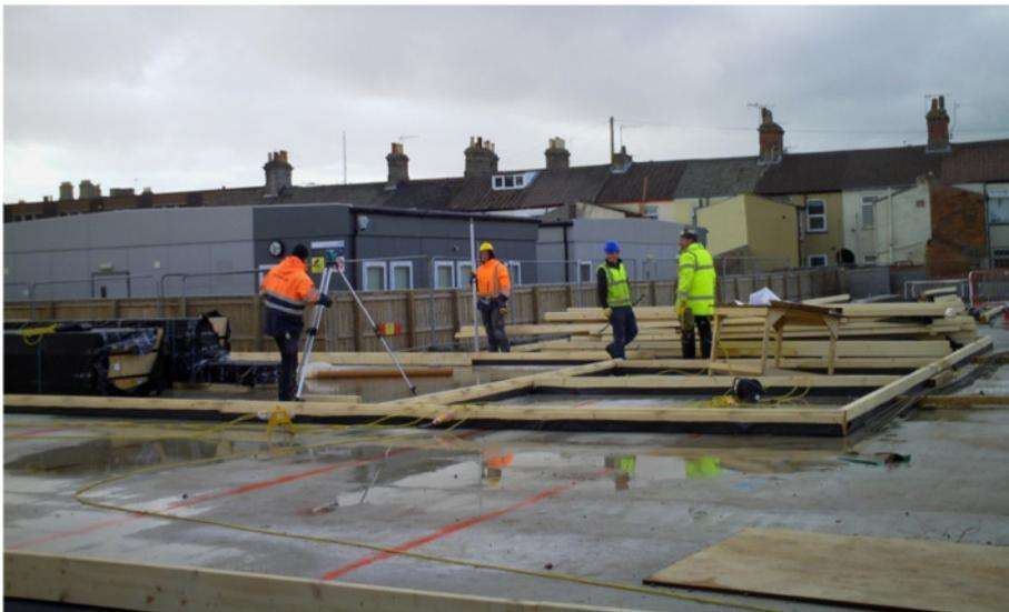
Bild 3.8 Montage der Schwellen im EG
