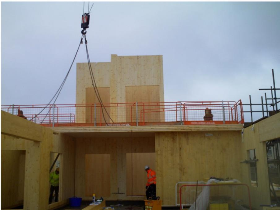
Bild 3.10 Montage Decke über EG
