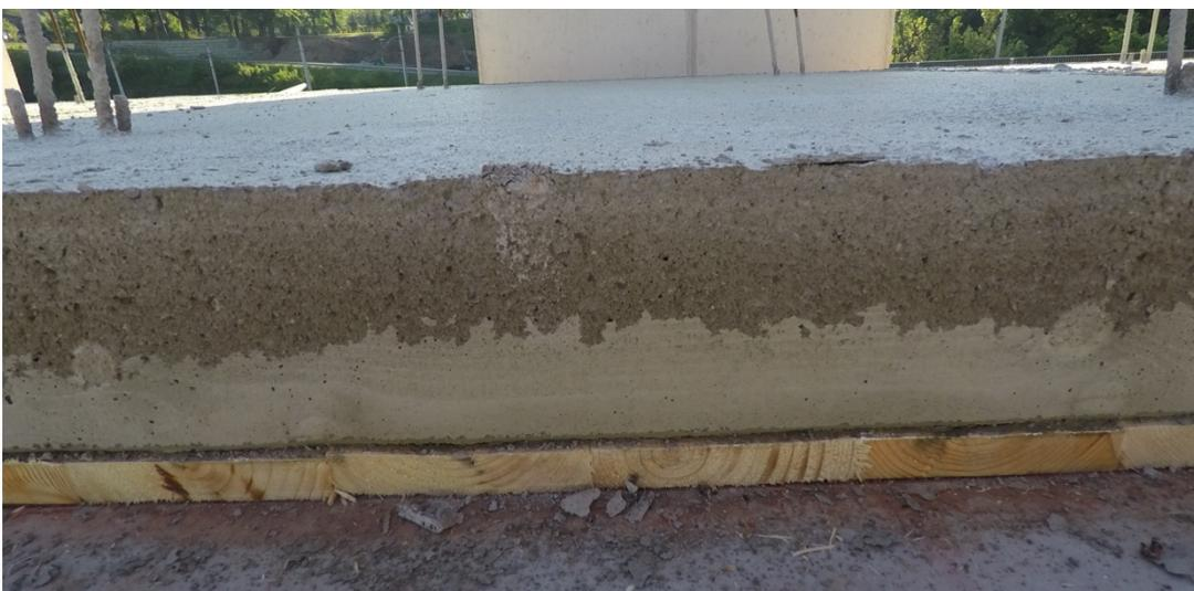
Abb. 315: Betonabriss der Fertigteile Abschnitt 1
