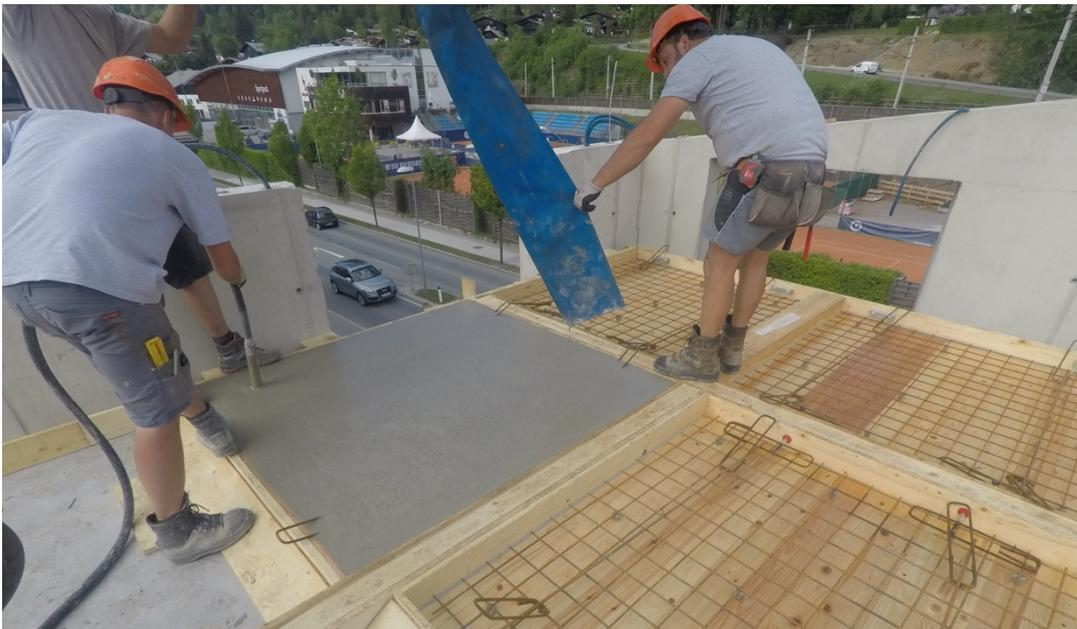
Abb. 323: Betonage der Fertigteile Abschnitt 2
