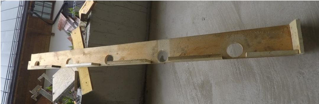
Abb. 335: Betonier- und Rüttelöffnungen der Fassade 7
