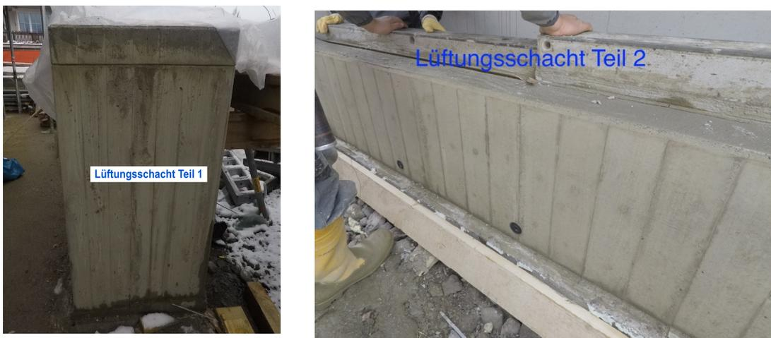
Abb. 420: Lüftungsschacht Teil 1 und 2 direkt nach dem Ausschalen
