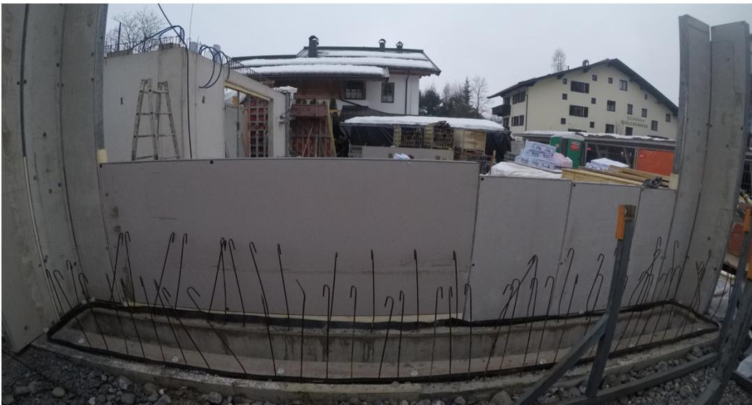
Abb. 121: Stellschalung mit Sichtbetonanforderung
