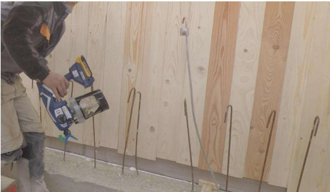
Abb. 93: Stellschalung vor dem Trennmittelauftrag
