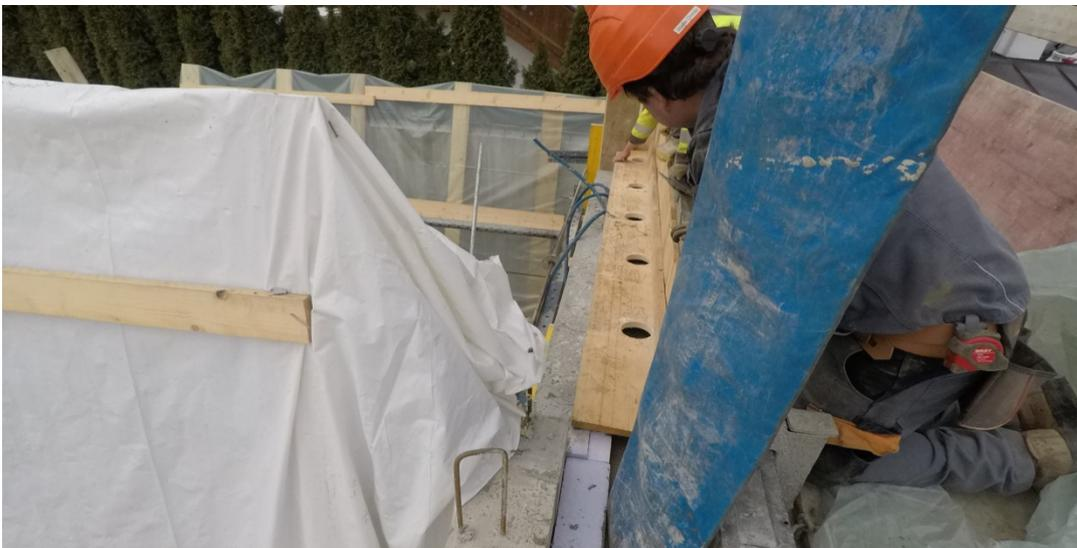
Abb. 212: Aufbringen der Rüttel- und Betonieröffnungen
