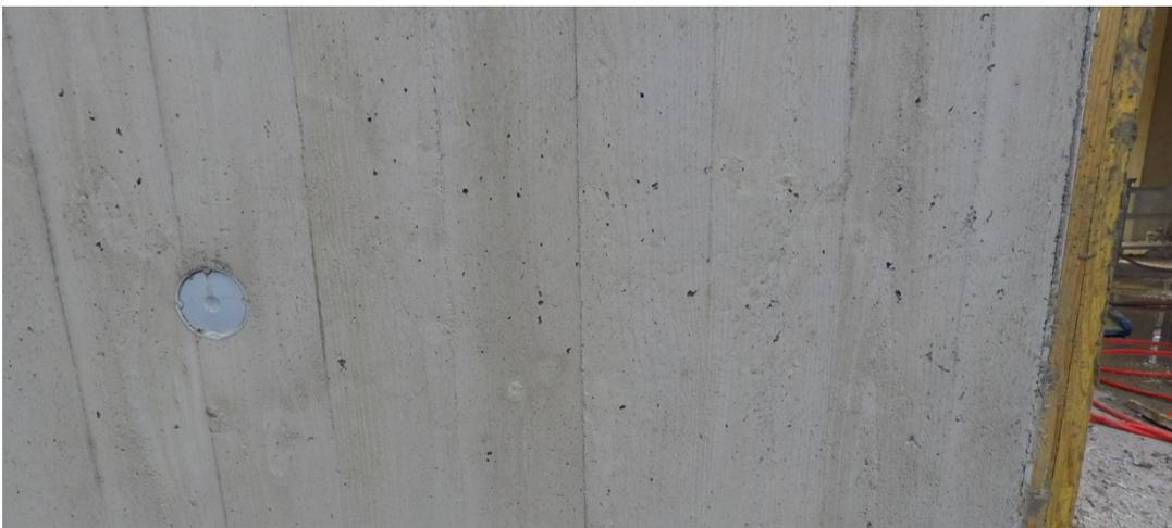
Abb. 297: Porigkeit der Fassade 6
