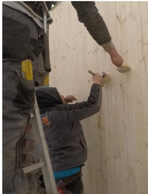
Abb. 241: Auftrag des Verdunstungsschutzes
