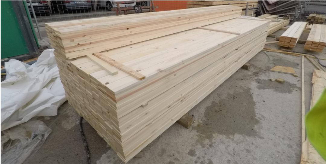
Abb. 12: Schalhautlagerung
