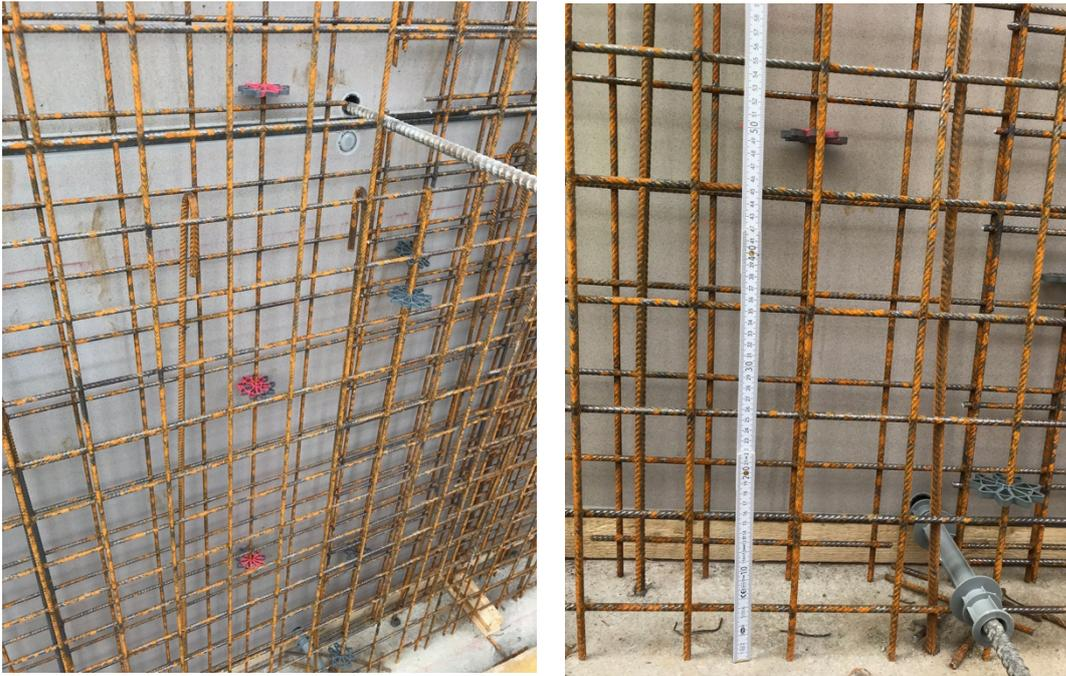
Abb. 43: Kennzeichnung der Schüttaghöhe
