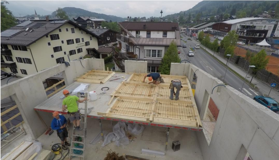
Abb. 307: Bewehren der Fertigteile Abschnitt 1
