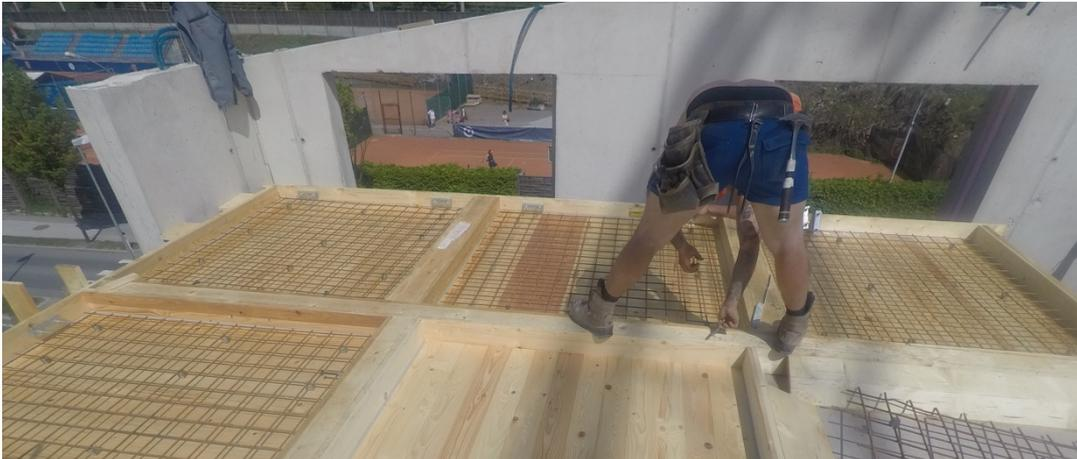
Abb. 320: Bewehren der Fertigteile Abschnitt 2
