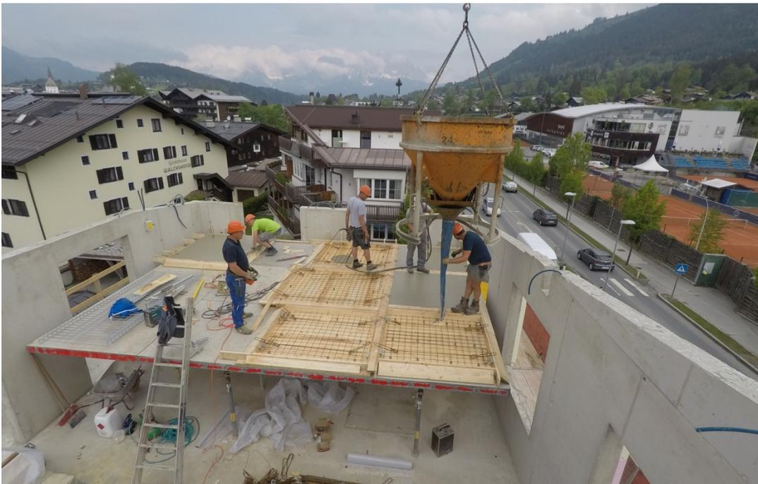
Abb. 310: Betonage der Fertigteile Abschnitt 1
