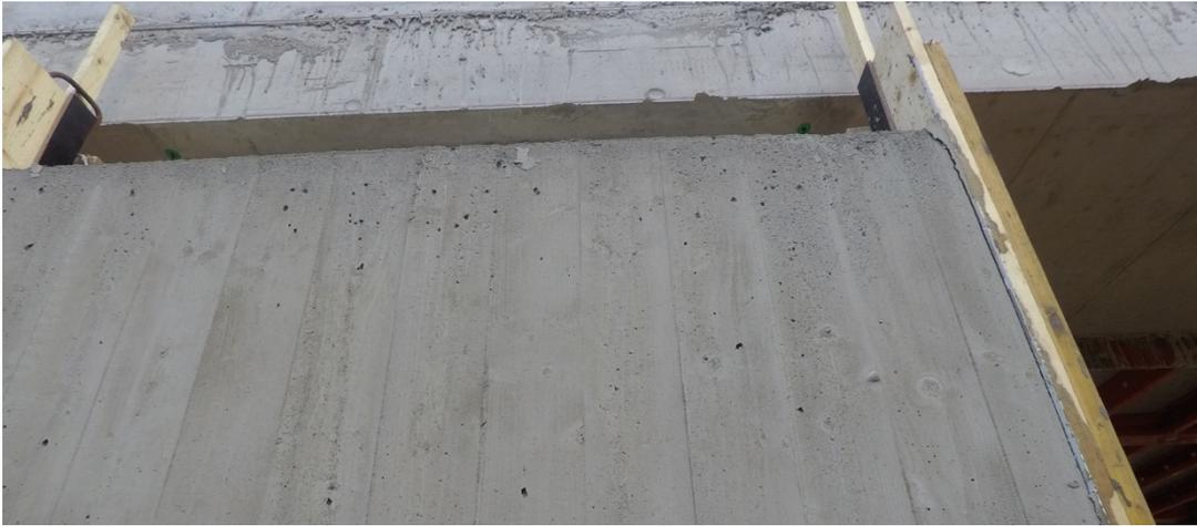
**Abb. 300: Betonabriss im oberen Bereich**
