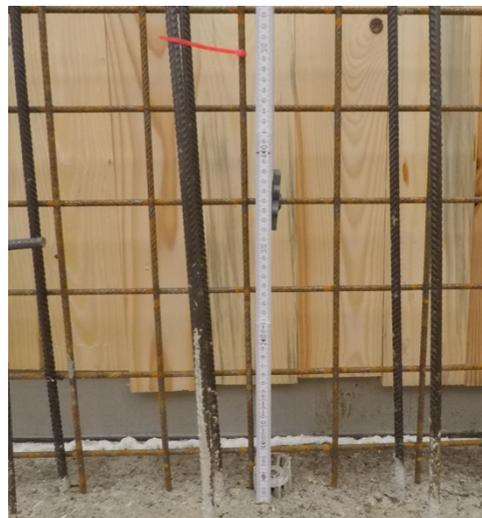
Abb. 72: Kennzeichnung der Schüttagenhöhe
