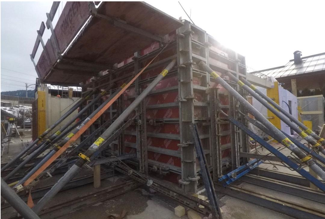
Abb. 188: Geschlossene Schalung von Fassade 1
