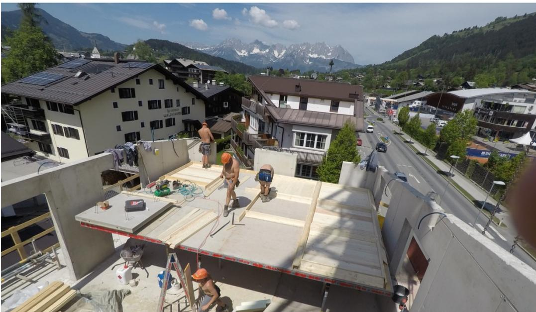
Abb. 318: Schalen und mit Brettern belegen der Fertigteile Abschnitt 2
