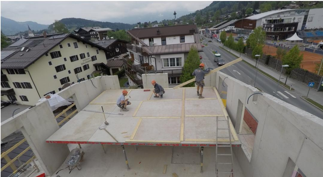
Abb. 305: Schalen der Fertigteile Abschnitt 1
