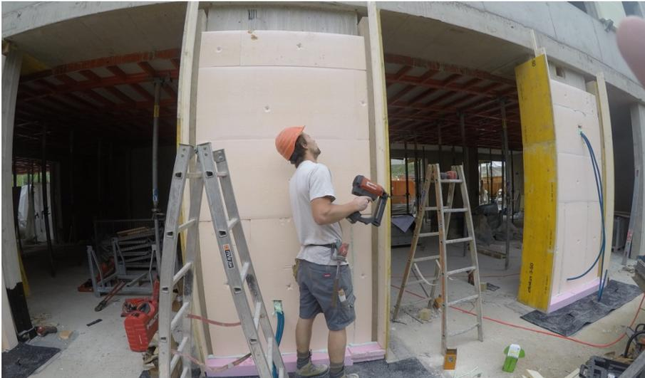
Abb. 292: Dämmung der Fassade 6
