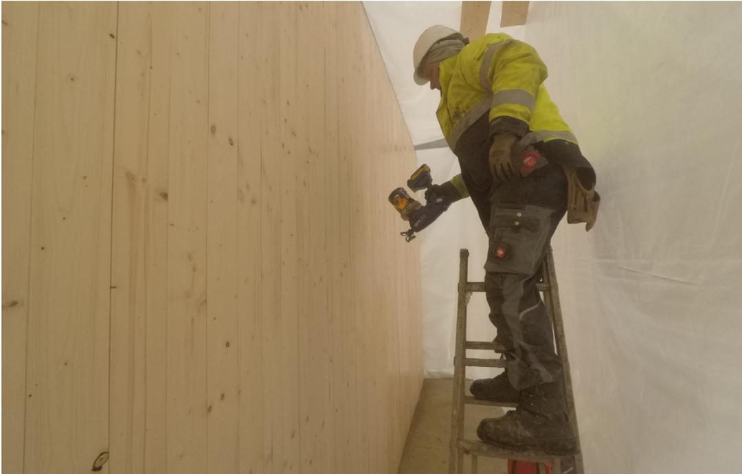
Abb. 208: Trennmittelauftrag Fassade 2
