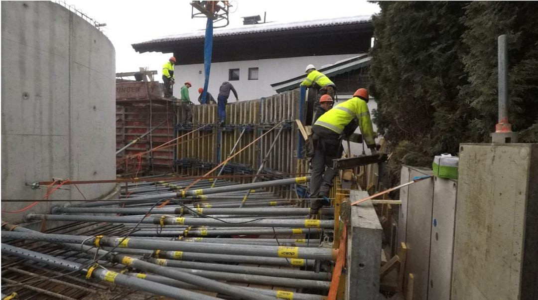
Abb. 108: Betonage der Tiefgaragenabfahrt Teil 1
