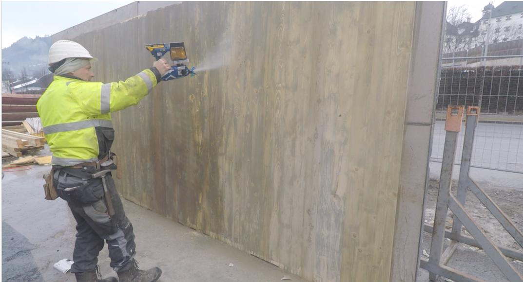
Abb. 50: Trennmittelauftrag Musterfläche 1
