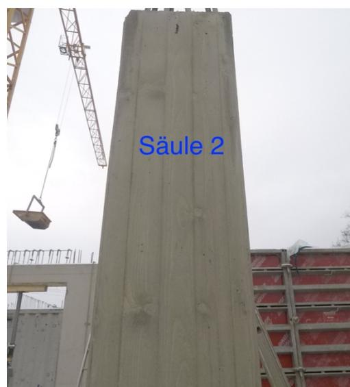
Abb. 424: Säule 1 und 2 direkt nach dem Ausschalen
