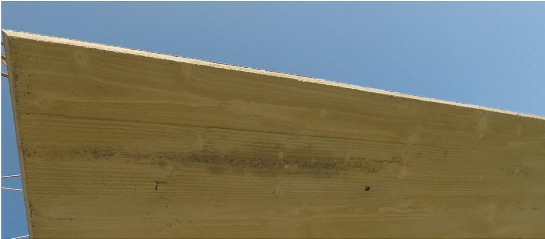
Abb. 313: Ergebnis der Fertigteile Abschnitt 1 direkt nach dem Ausschalen
