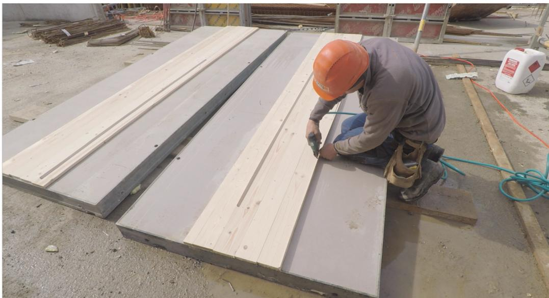
Abb. 132: Befestigung der Dreikantleiste auf die Schließschalung von Säulen 1 und 2
