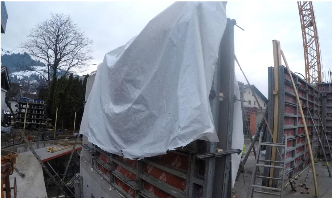
Abb. 98: Schutz der fertiggestellten Schalung vor Witterung
