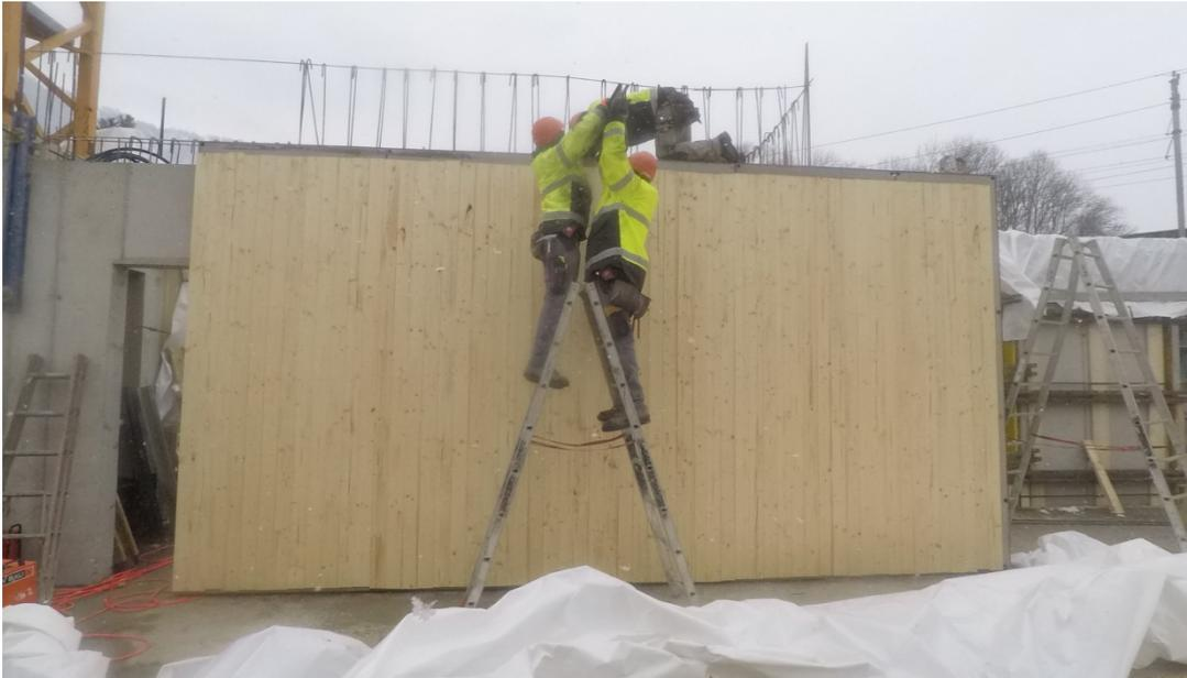
Abb. 206: Schalung belegen Fassade 2
