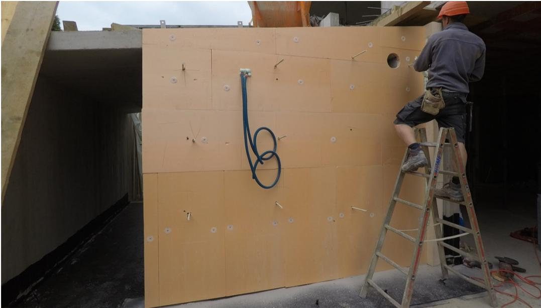
Abb. 331: Anschlussbewehrung der Fassade 7
