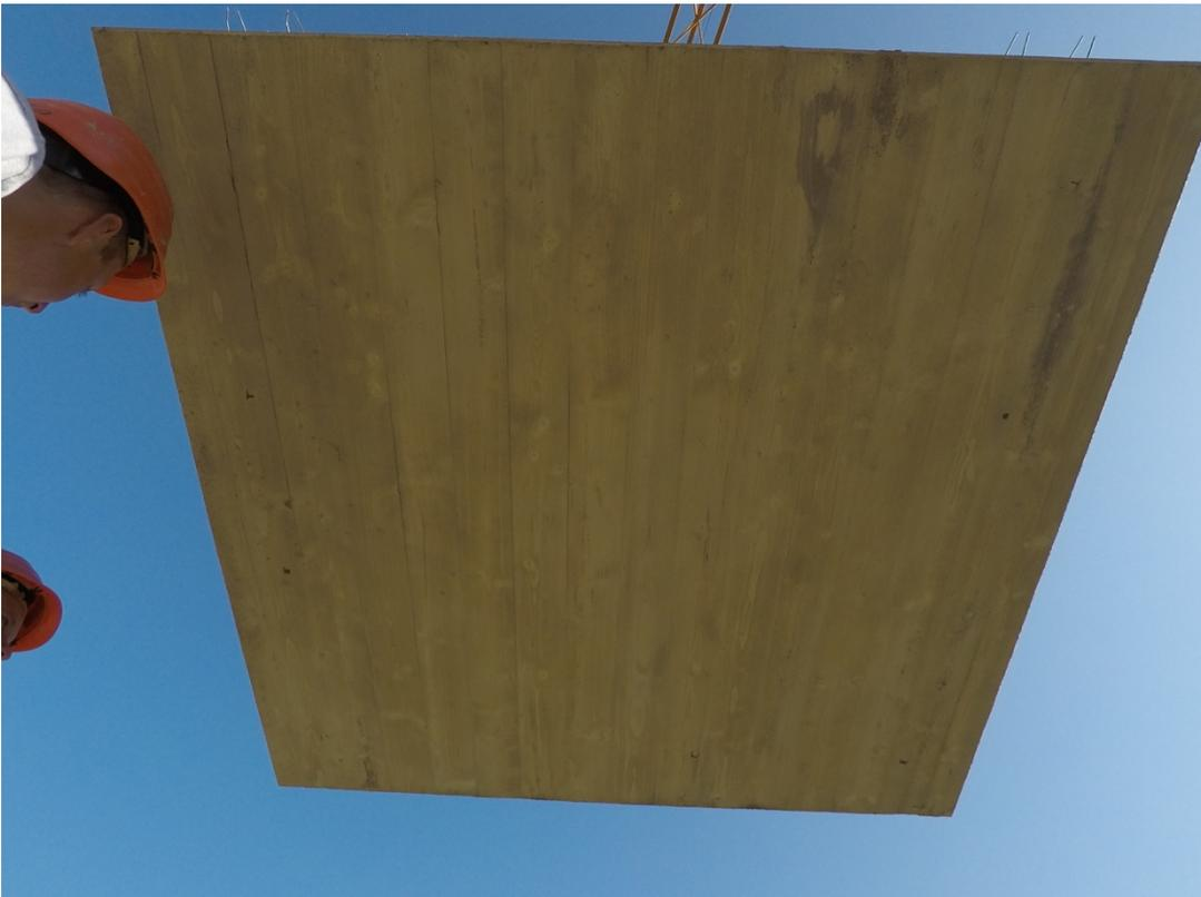
Abb. 312: Ergebnis der Fertigteile Abschnitt 1 direkt nach dem Ausschalen
