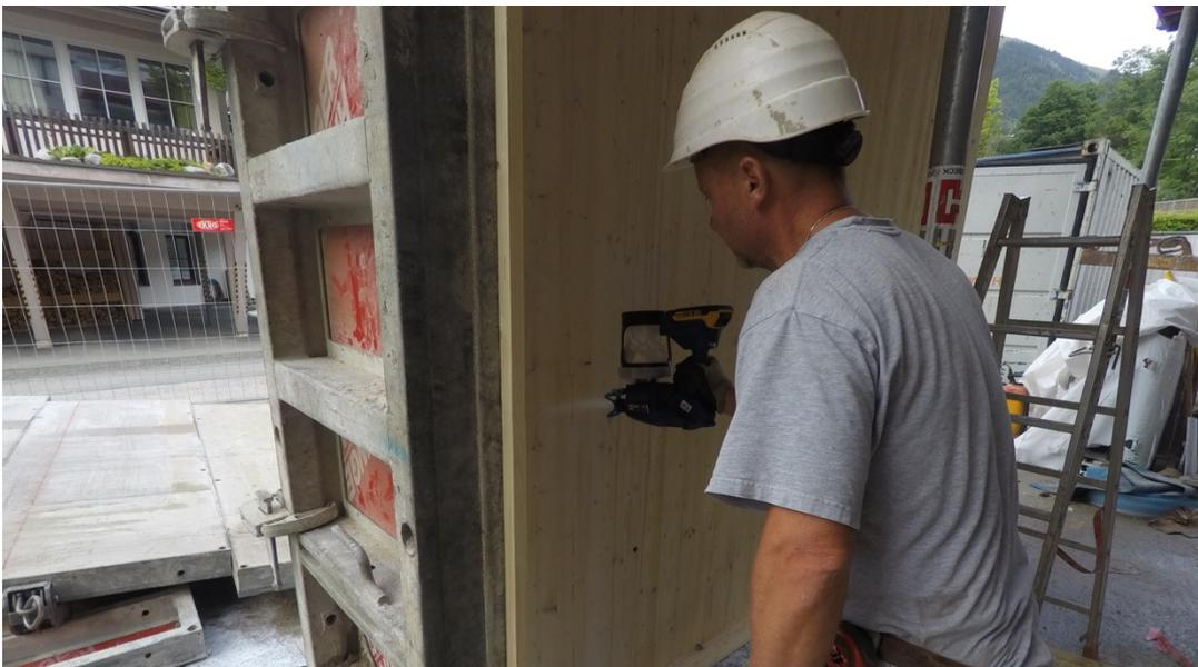
Abb. 372: Auftrag Flüssigwachs
