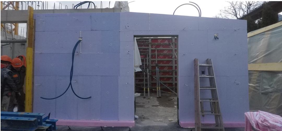
Abb. 204: Dämmung der Fassade 2
