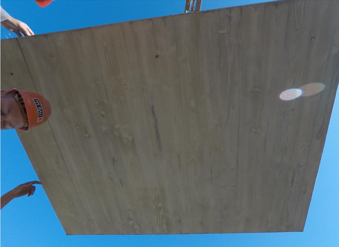
Abb. 311: Ergebnis der Fertigteile Abschnitt 1 direkt nach dem Ausschalen
