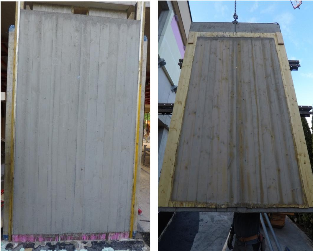
Abb. 286: Vergleich der Betonoberfläche mit der Schalhaut direkt nach dem Ausschalen
