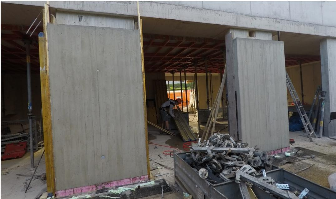
Abb. 299: Fassade 5 und Fassade 6 direkt nach dem Ausschalen
