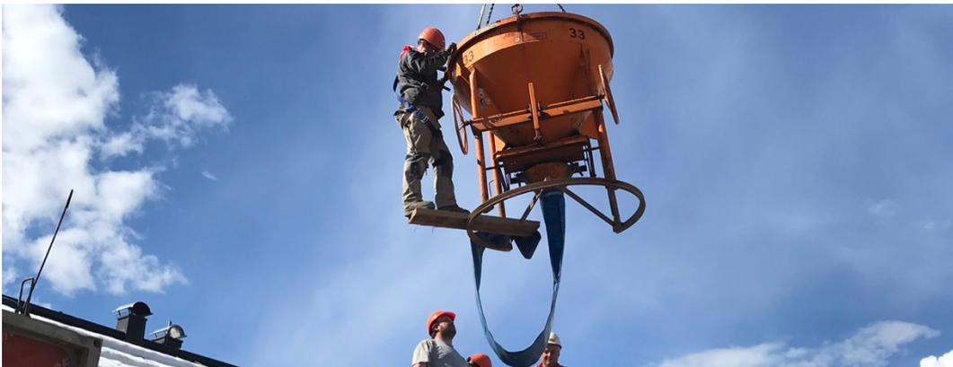
**Abb. 75: Betonage der Musterfläche 2**
