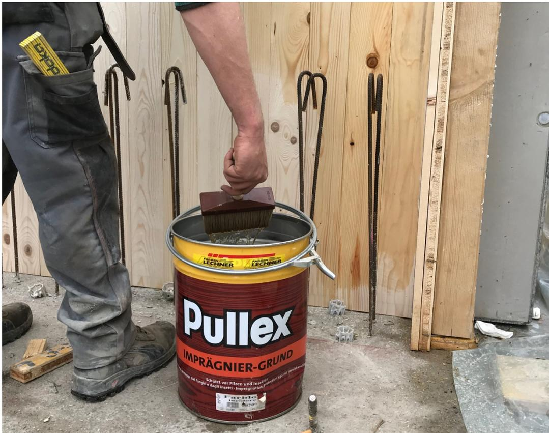
Abb. 148: Imprägnier-Grund Auftrag
