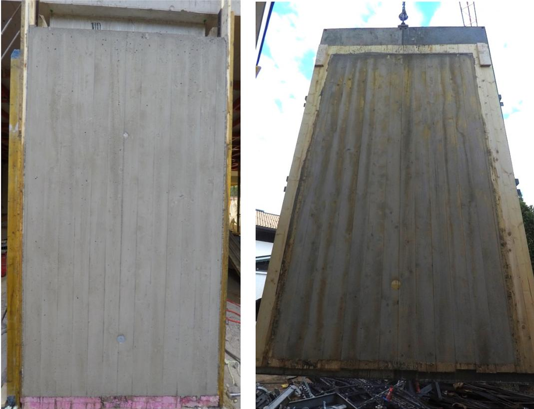
Abb. 298: Vergleich der Betonoberfläche mit der Schalhaut direkt nach dem Ausschalen
