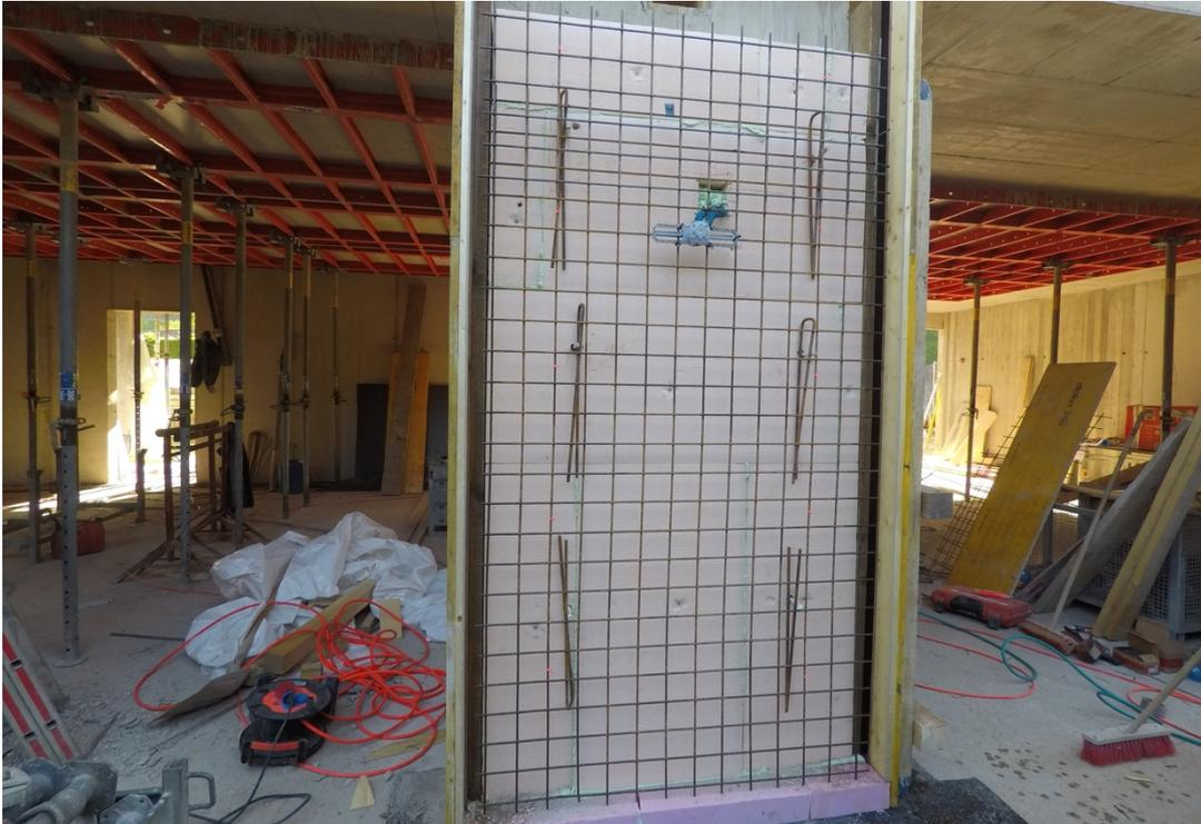
Abb. 278: Dämmung und Bewehrung der Fassade 5
