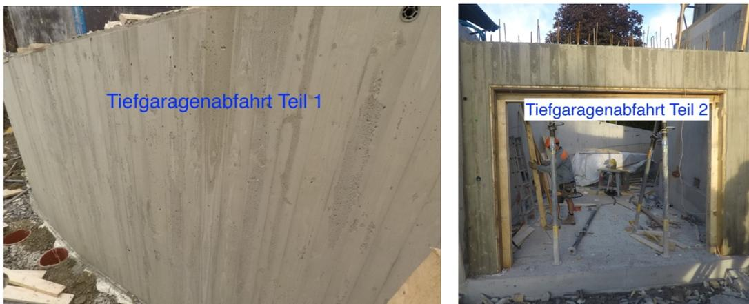
Abb. 421: Tiefgaragenabfahrt Teil 1 und 2 direkt nach dem Ausschalen
