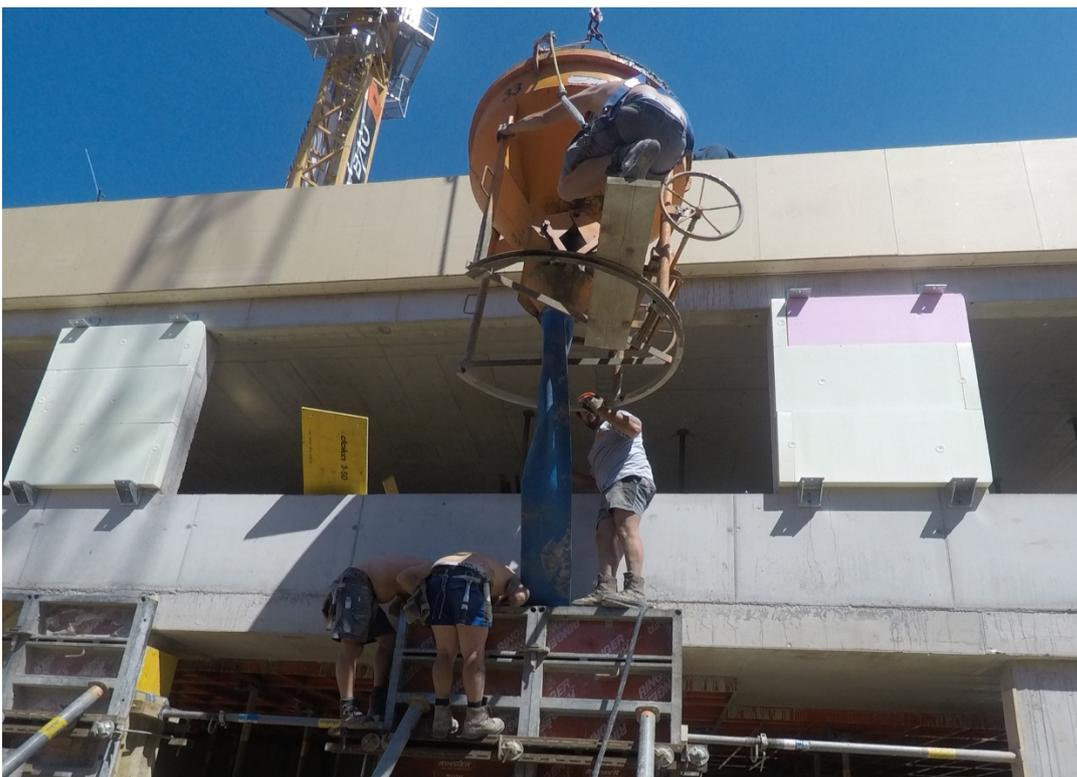
Abb. 284: Betonage der Fassade 5
