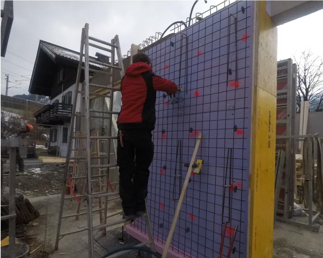
Abb. 239: Dämmung und Bewehrung der Fassade 4
