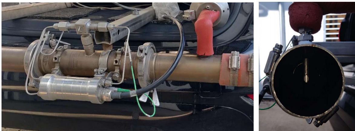
Abbildung 3-4: Massenstrommesser (links) und PEMS-Entnahmestelle (rechts)
