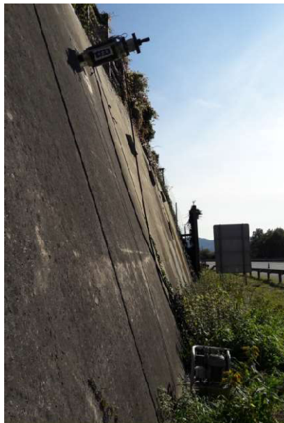
Abb. 1: Abhebekontrolle in ungefähr 5 m Höhe
