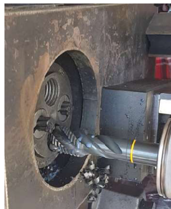
Abb. 27: Links: Aufweitung eines Litzenloches mittels Spiralkernbohrer; Rechts: Herstellung eines Innengewindes an einer unter Spannung stehenden Keilscheibe
