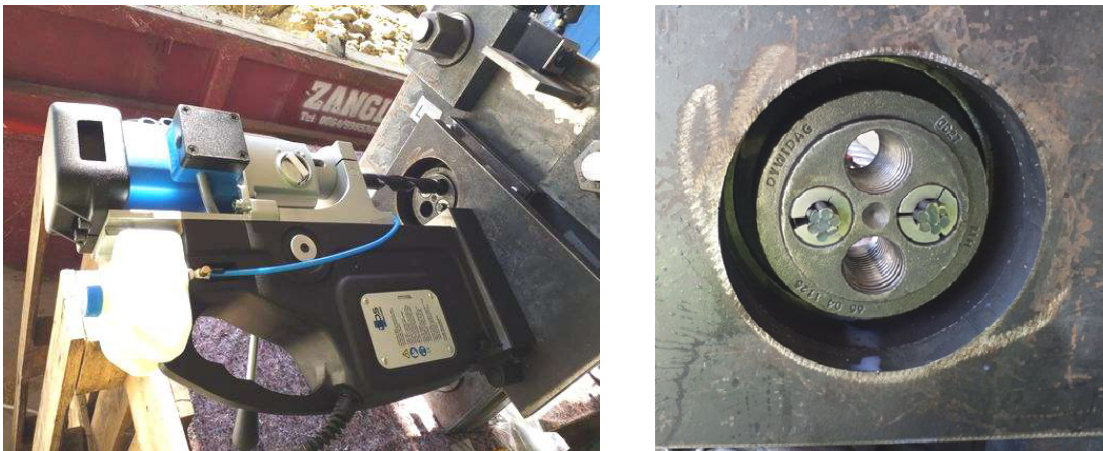
Abb. 35: Links: Eingerichtete Magnetständerbohrmaschine auf der Bohrplattform; Rechts: Erfolgreich hergestelltes Innengewinde in eine Keilscheibe
