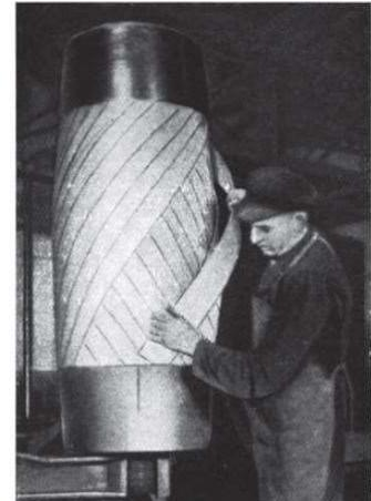
Abbildung 4-5: geschlossene Biegekörper (links); Herstellung Sperrholzfass (rechts) [12]
