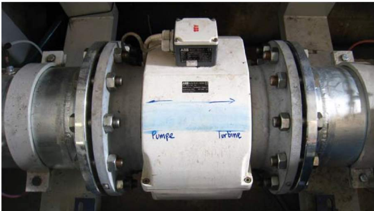
Abbildung 41: IDM250 in eingebautem Zustand
