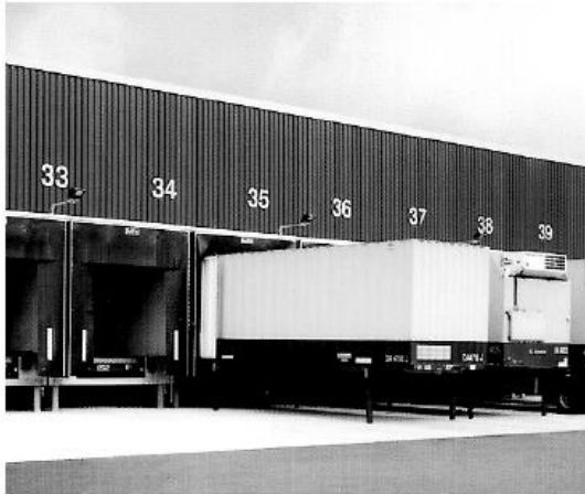
Bild 2.15 Ladung an einer Laderampe mit Kopframpe 59
