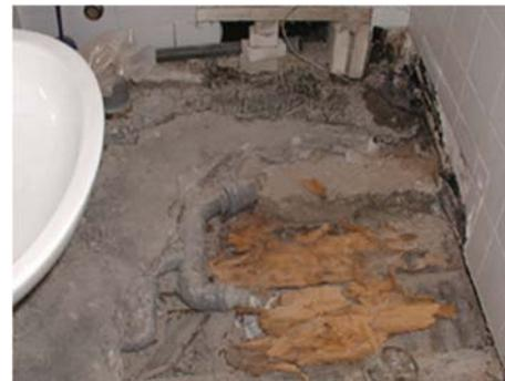
*Abbildung 1.8: Weißfäule am Deckenbalken [14]*
