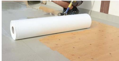
Abbildung 3.4: Flüssigkunststoff mit Vlieseinlage [76]
