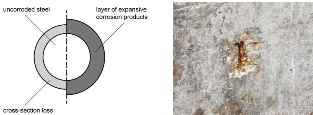
Abb. 36: Links: Schematische Darstellung des Querschnittsverlustes und der Expansion der Korrosionsprodukte (Angst u. a., 2012); Rechts: Betonabplatzung zufolge eines Korrosionsschadens an der Bewehrung
