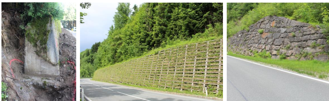
Abb. 3: Links: Querschnitt einer Gewichtskonstruktion aus Beton, Mitte: Raumgitterwand, Rechts: Steinschichtkörper
