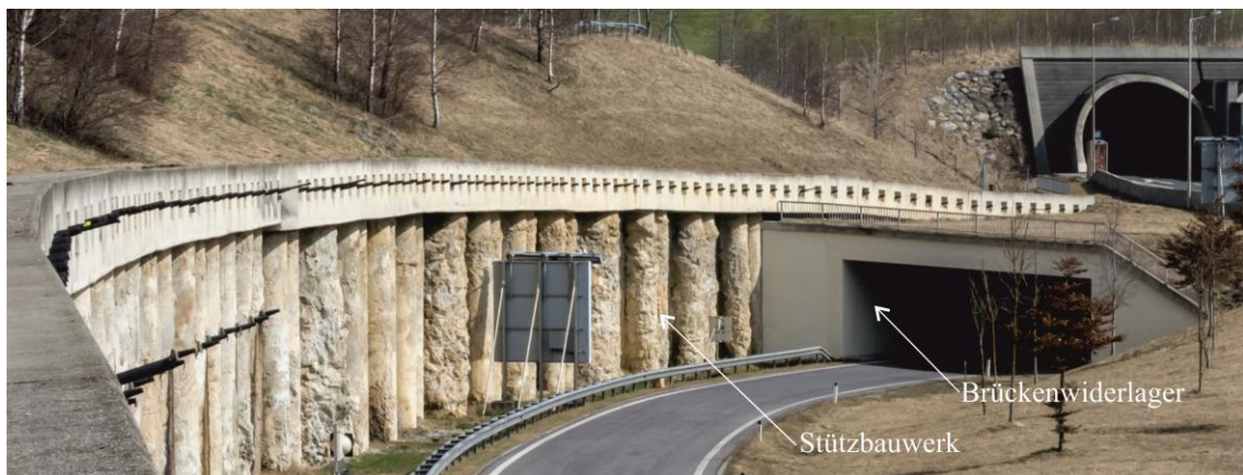
Abb. 78: Vergleich zwischen Brückenwiderlager und Stützbauwerk
