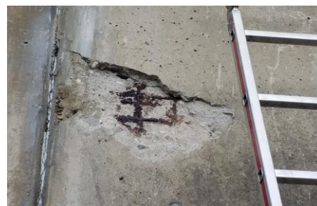
Abb. 17: Links: Oberflächennahe Betonschäden, Rechts: Freigelegte Bewehrung
