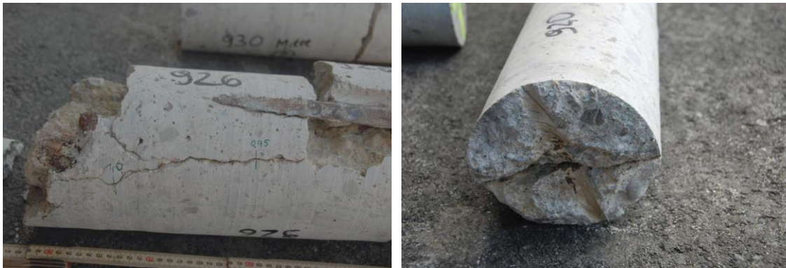
Abb. 41: Links: Detail zu Abb. 40; Rechts: Ansicht der Stirnseite einer Kernbohrung und für Materialproben entnommenem Bewehrungsseisen (siehe Abb. 47)
