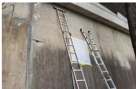
Abb. 17: Links: Oberflächennahe Betonschäden, Rechts: Freigelegte Bewehrung
