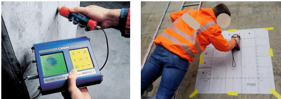
Abb. 49: Links: Anwendung der Potentialfeldmessung an einer Stahlbetonstütze ( Sodeikat, 2010 ); Rechts: Anwendung der ferromagnetischen Bewehrungsdetektion bei einer Winkelstützmauer
