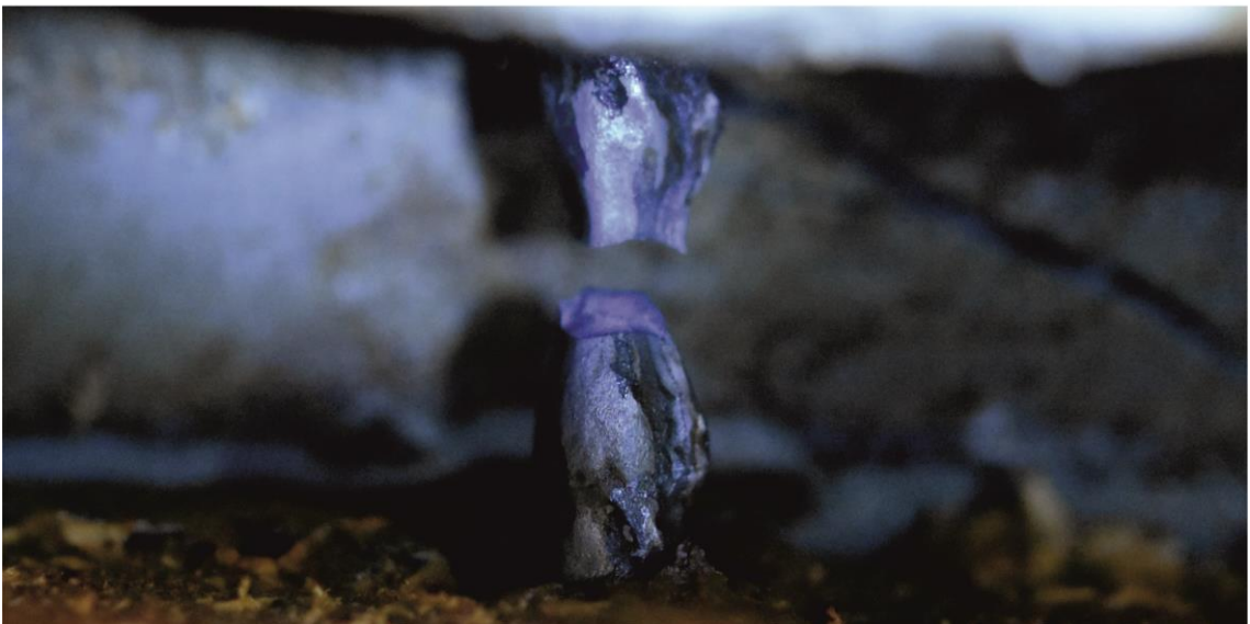
Abb. 106: Zeitlicher Verlauf des Korrosionsprozesses an einem Bewehrungsseisen
