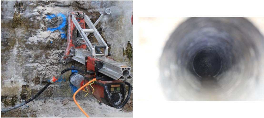
Abb. 21: Links: Kernbohrungen bei Stützbauwerken, Entnahme der des Bohrkerns mittels Bohrgerät; Rechts: Bohrloch mit anstehendem Hinterfüllungsmaterial
