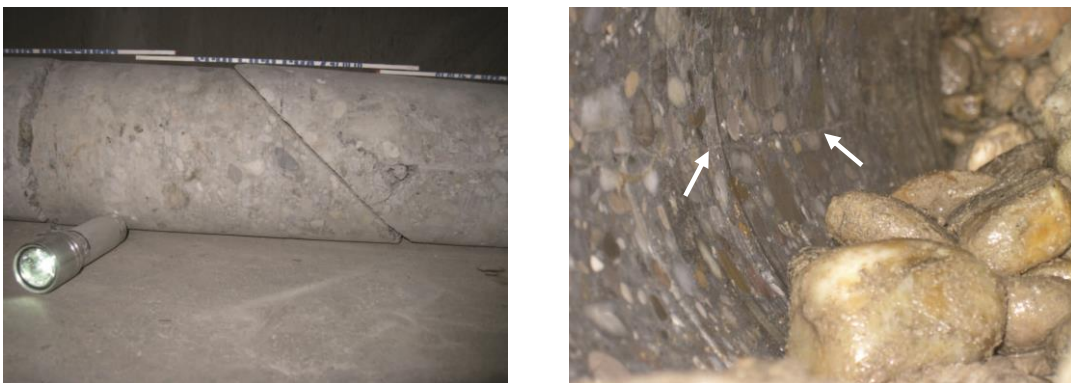
Abb. 42: Links: Ansicht einer Kernbohrung geneigt durch eine Arbeitsfuge; Rechts: Ansicht der Arbeitsfuge im Inneren einer Kernbohrung (ASFINAG)
