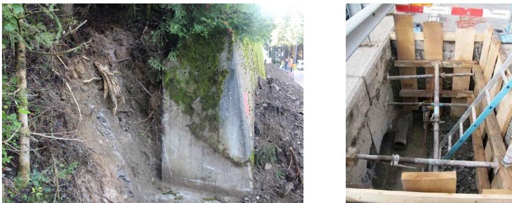
Abb. 23: Teilabbruch bei Stützbauwerken; Links: Freigelegter Querschnitt einer Gewichtskonstruktion; Rechts: Schachtung hinter einer Winkelstützmauer (Opan, 2017)
