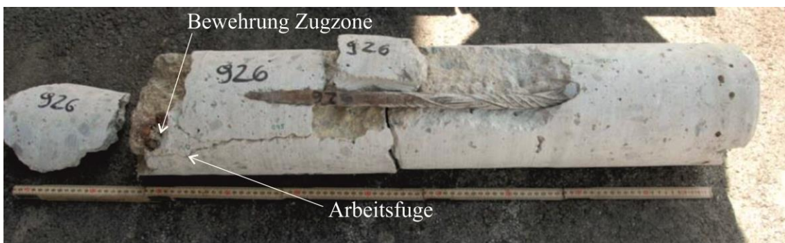
Abb. 40: Kernbohrung durch eine Arbeitsfuge ( ASFINAG )
