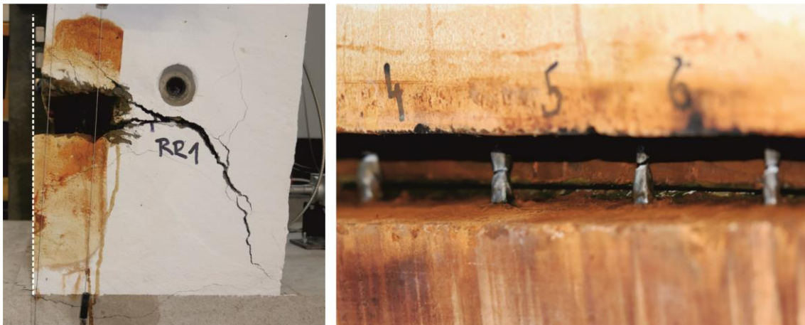
Abb. 113: Versagte Versuchskörper; Links: Seitenansicht der Korrosionsfuge mit geöffneter Fuge; Rechts: Korrodierte und durch Zugbeanspruchung (inkl. Einschnürung) versagte Bewehrungseisen
