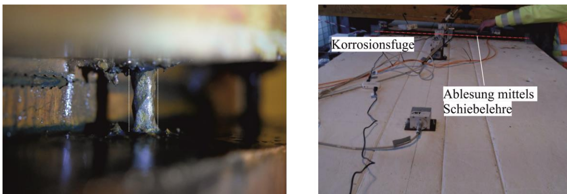
Abb. 130: Links: Korrosionsverteilung entlang eines Stabes; Rechts: Bestimmung des vorhandenen Restquerschnittes mittels Schiebelehre
